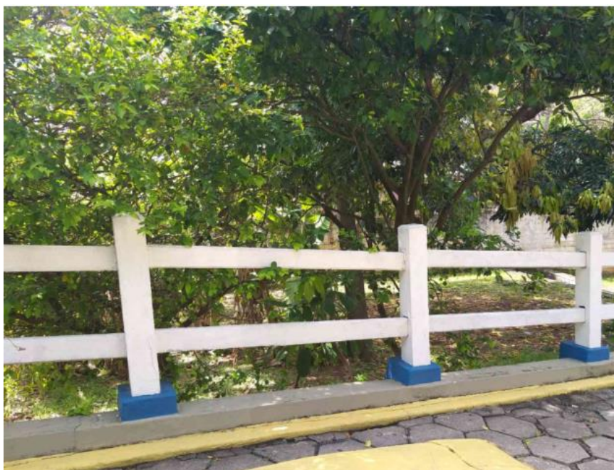
Figura 1 - Exemplo guarda corpo
