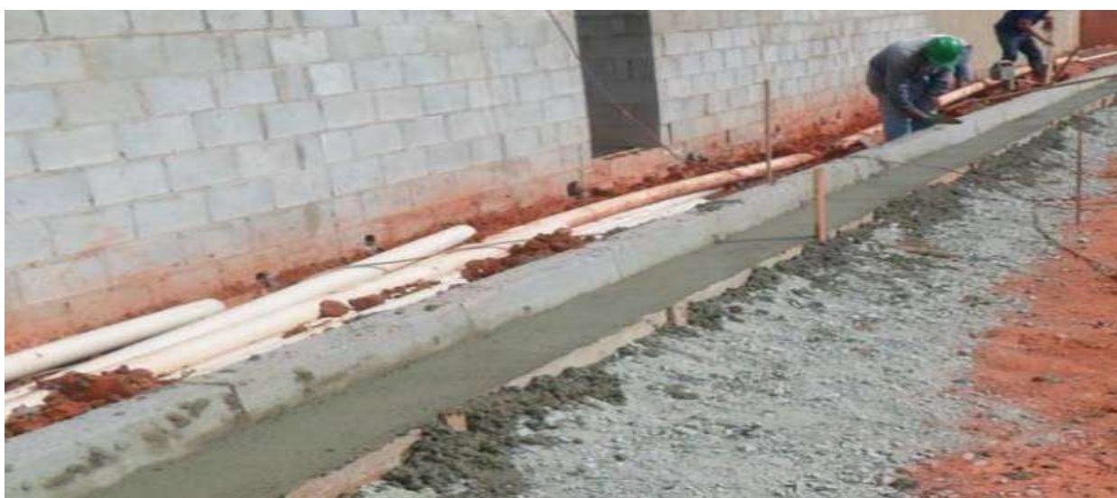
Figura 3: Exemplo de execução de sarjeta moldada in-loco
