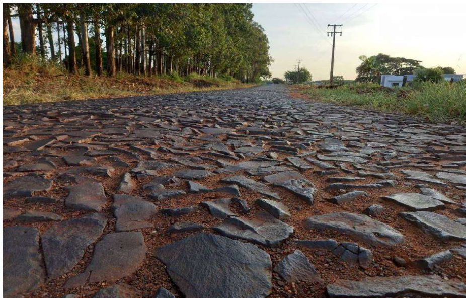
Figura 5: Exemplo de alvenaria poliédrica
