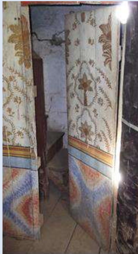
P04B VISTA INTERNA
