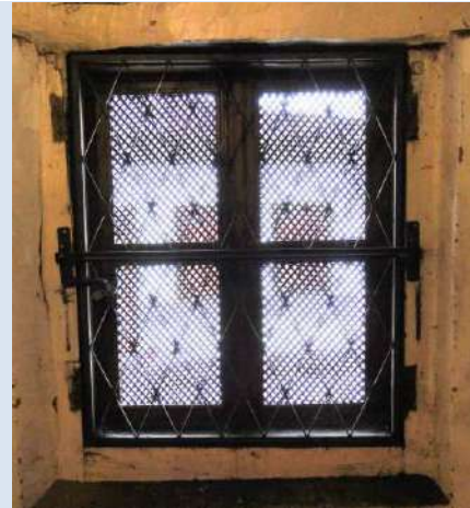
J01T VISTA INTERNA
