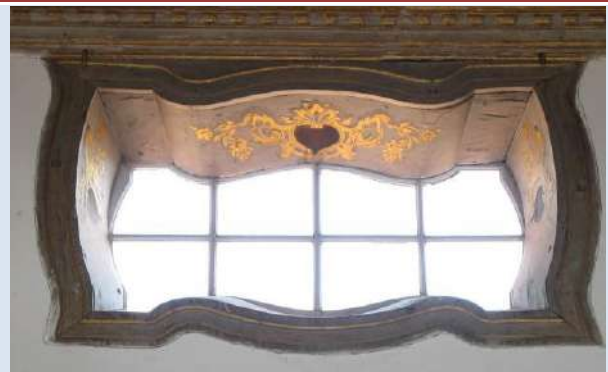
OC3B VISTA INTERNA
