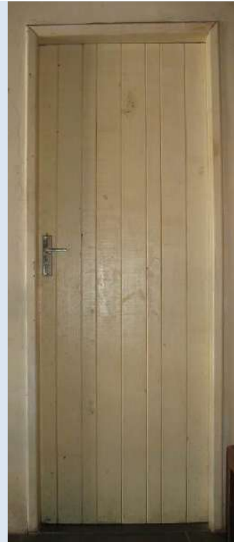
P05T VISTA INTERNA
