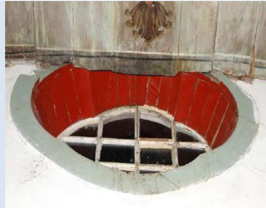
OC2B VISTA INTERNA
