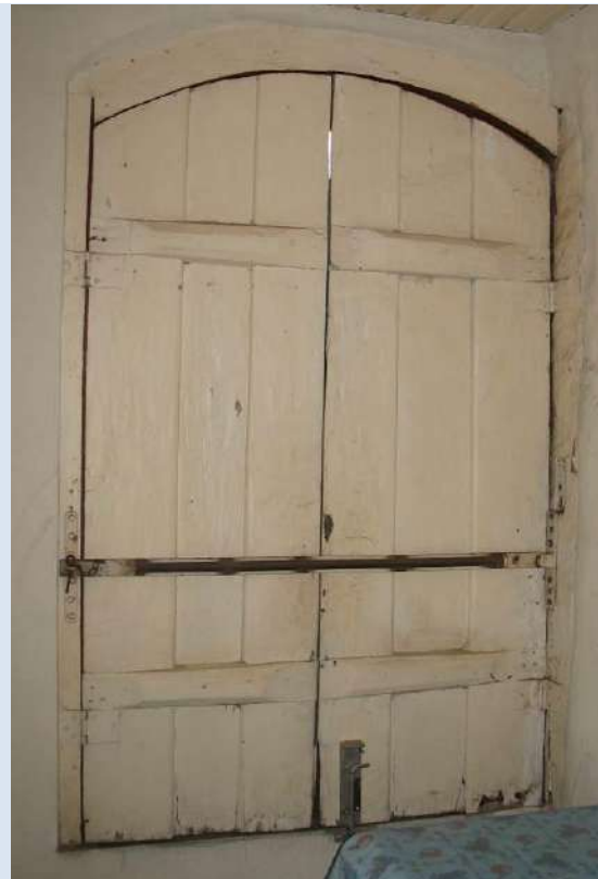
J02T VISTA INTERNA
