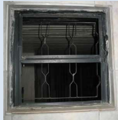
J05T VISTA INTERNA
