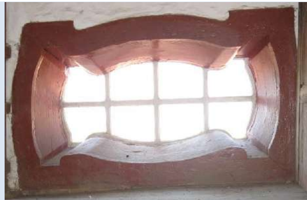
OC6B VISTA INTERNA
