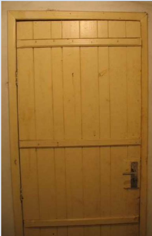
P05T VISTA EXTERNA
