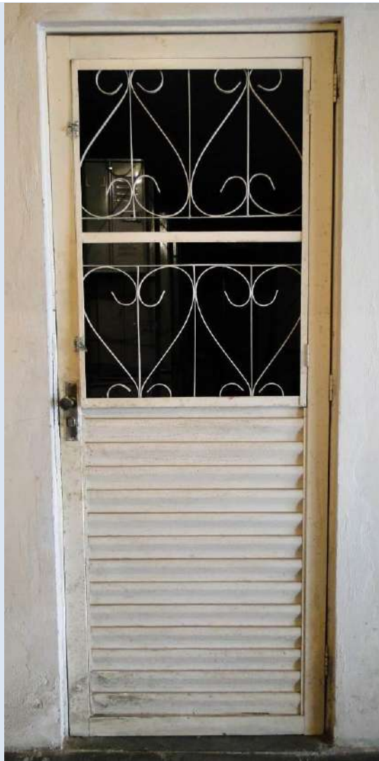
P04T VISTA EXTERNA
