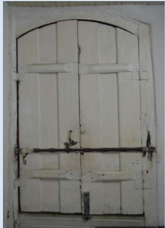
J04T VISTA INTERNA
