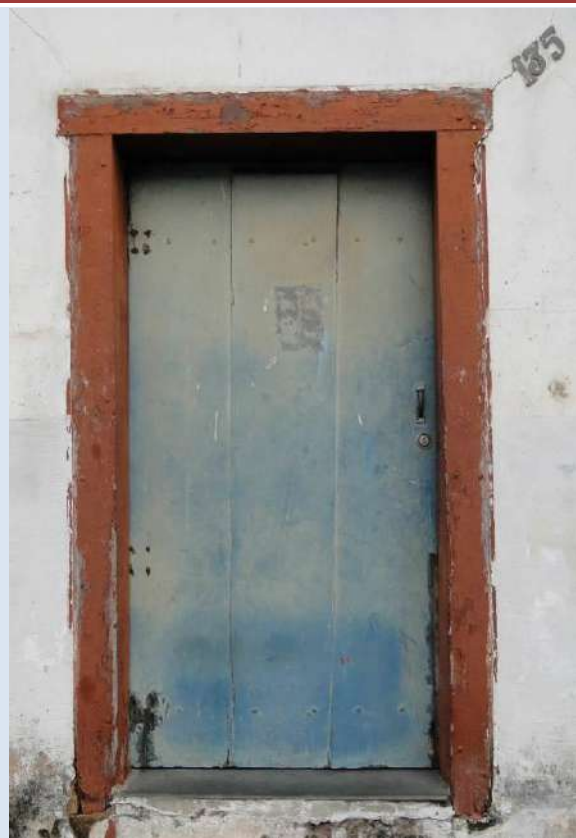
P01T VISTA EXTERNA
