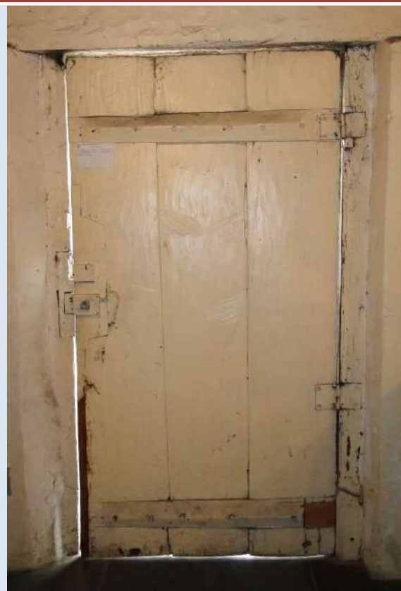
P01T VISTA INTERNA
