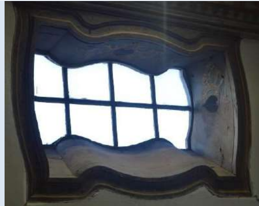
OC4B VISTA INTERNA
