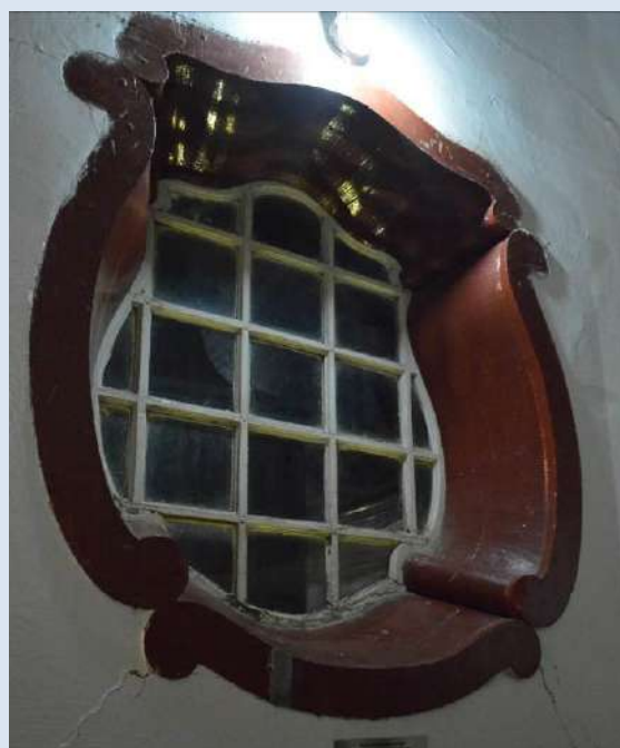
OC1B VISTA INTERNA
