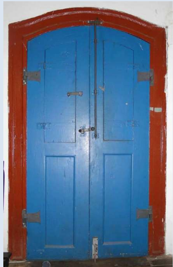
P01B-E VISTA INTERNA
