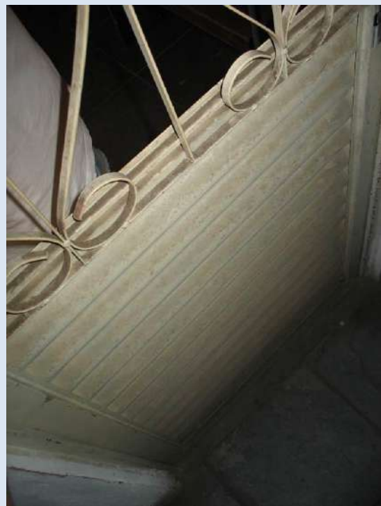
P04T VISTA INTERNA
