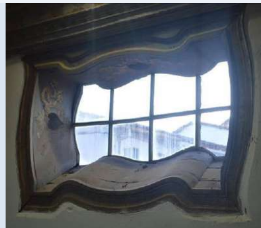
OC5B VISTA INTERNA
