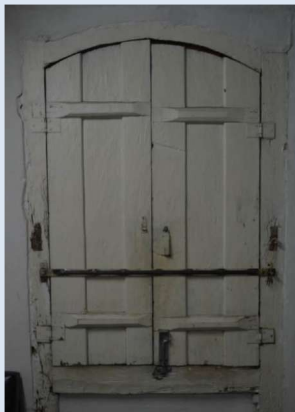
J03T VISTA INTERNA
