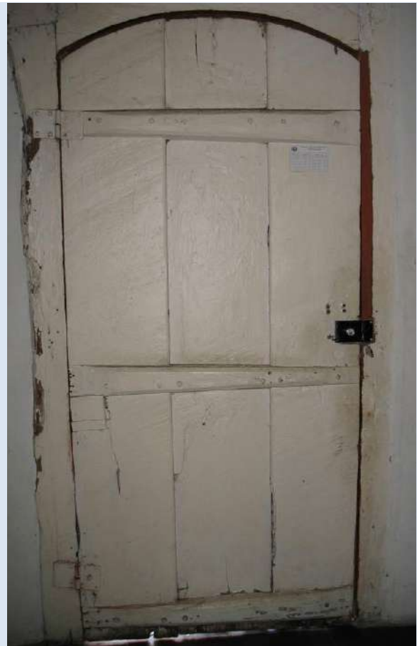
P02T VISTA INTERNA
