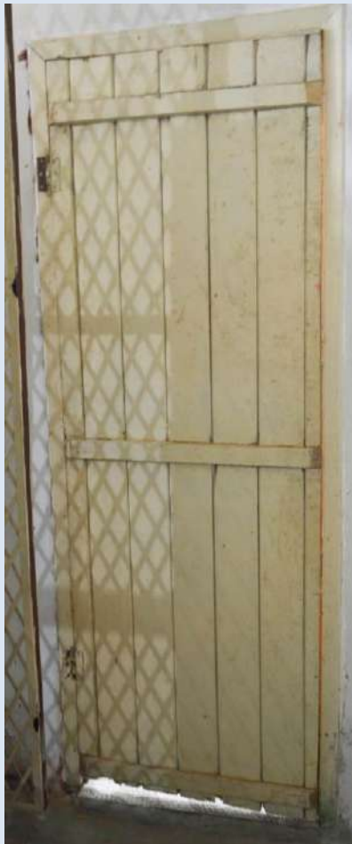
P03T VISTA EXTERNA
