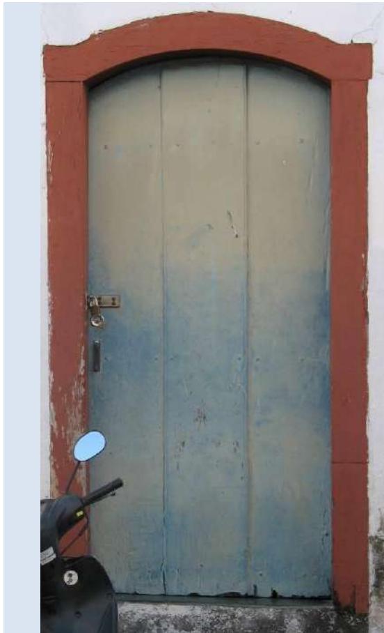
P02T VISTA EXTERNA
