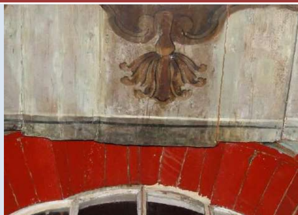
Mancha por ação da umidade
