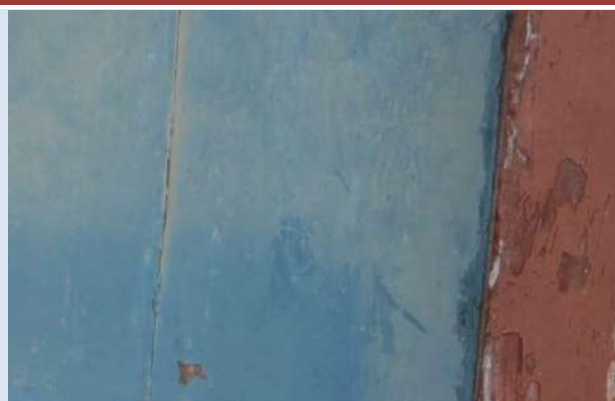
Desbotamento da Pintura
