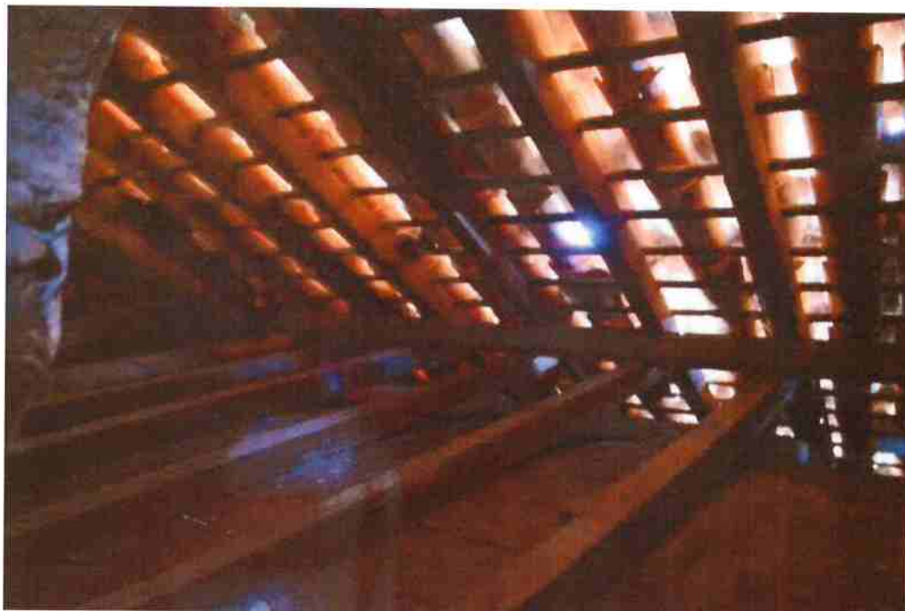
Vista geral da parte estrutural do forro da capela-mor
