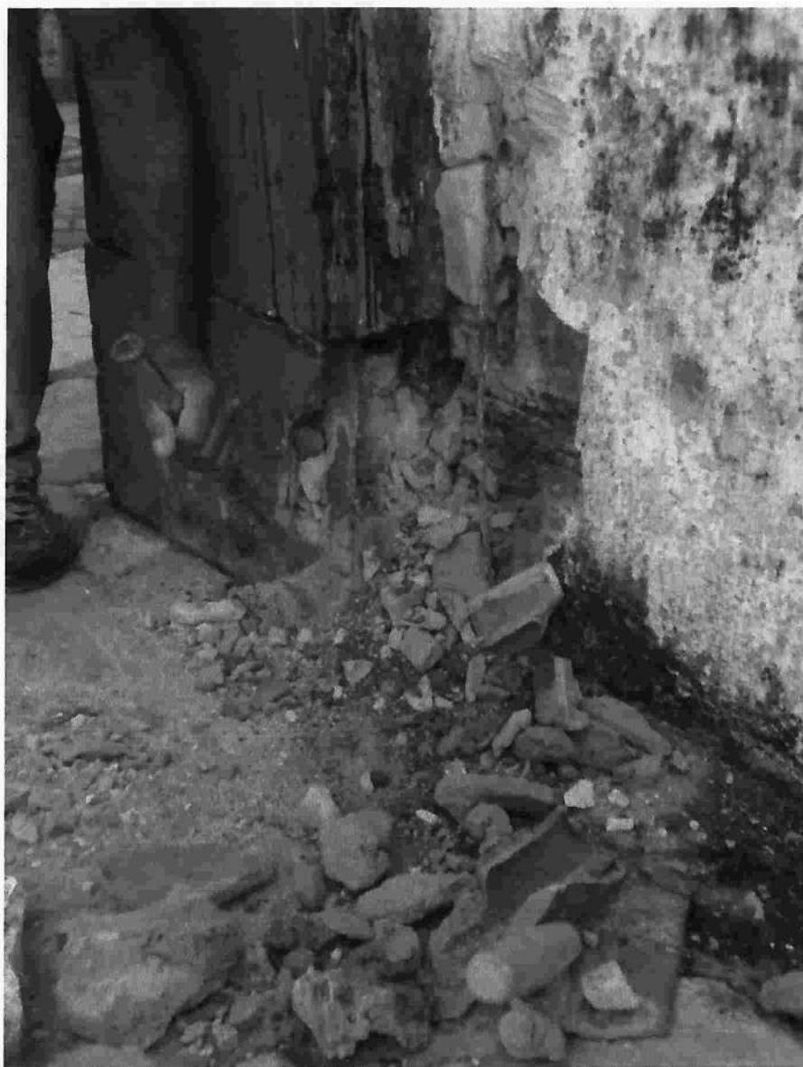
FIGURA 1 – Prospecção para avaliação do estado estrutural e fitossanitário dos pilares externos.
