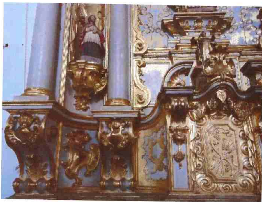
Fig.51 Retábulo de Santo Elias_vista frontal mísulas de sustentação das colunas
