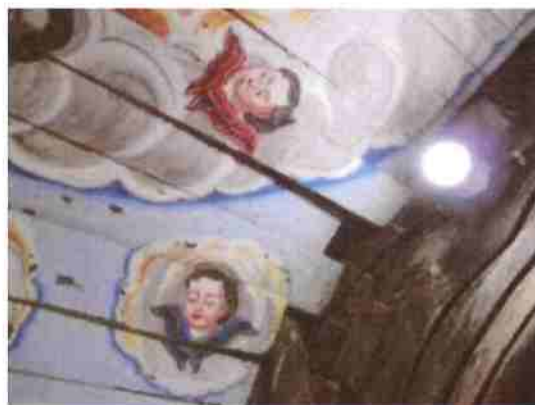
Desajuste e desprendimento de encaixes do tabuado na forração da lateral do camarim
