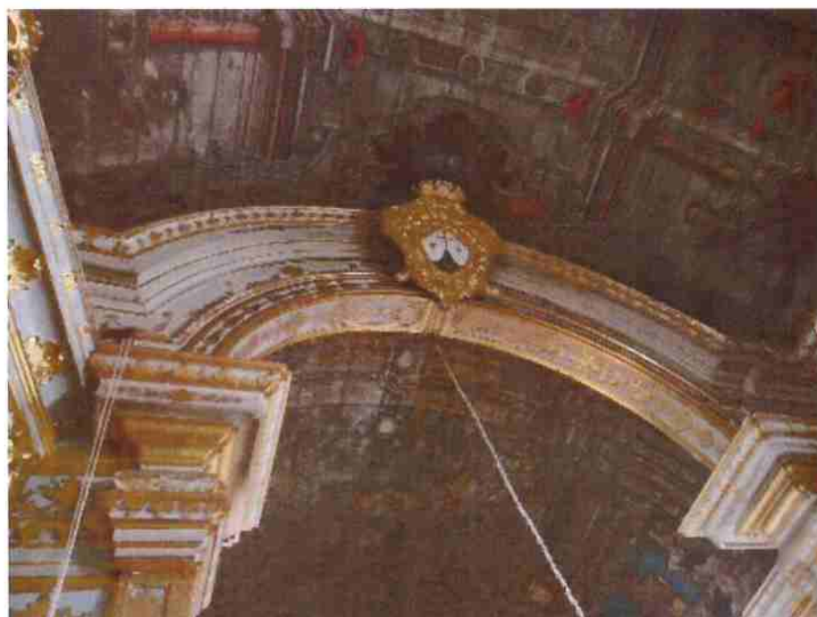
Fig.32 Entablamento e tarja do arco cruzeiro
