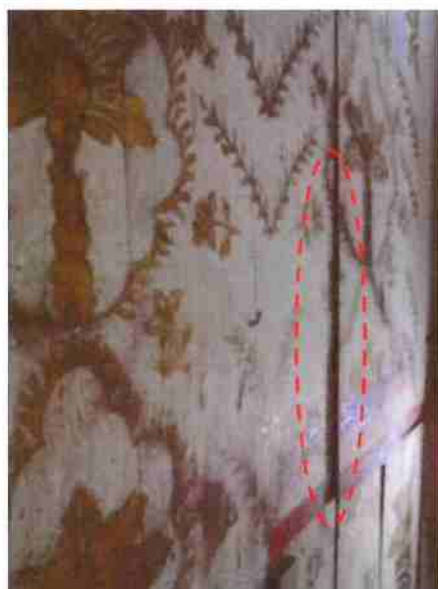
Desajuste e desprendimento de encaixes do tabuado na forração da lateral do camarim
