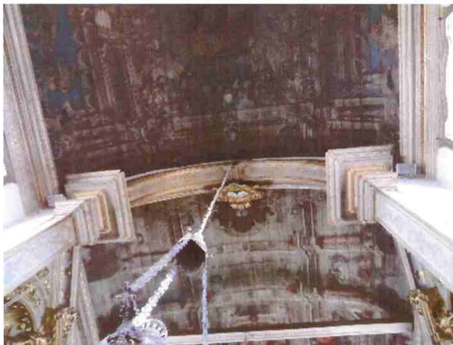
Fig.31 Intradorso das pilastras de estruturação e do fechamento do arco cruzeiro
