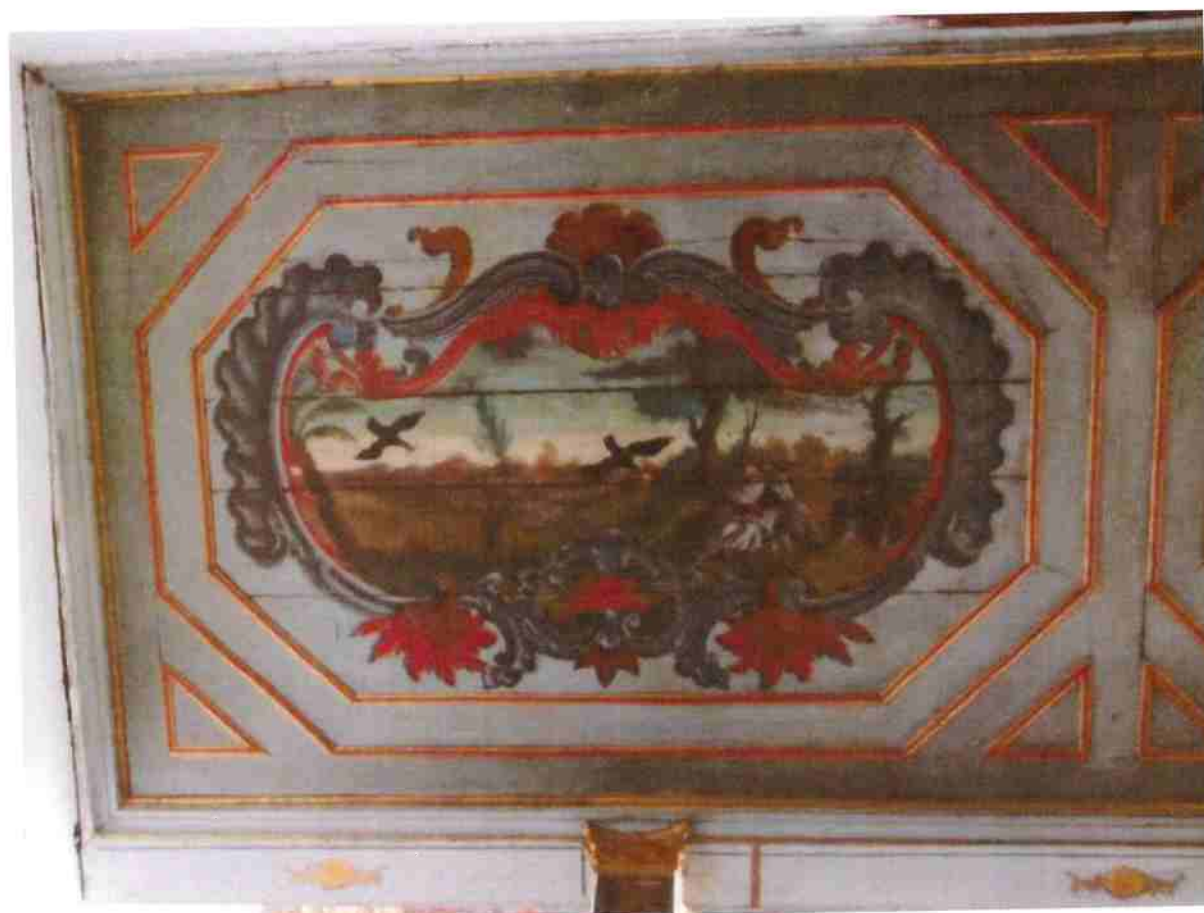
Fig.97 Forro do átrio_painel do lado esquerdo
