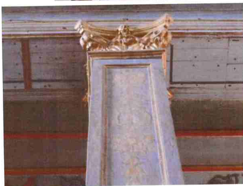
Fig.100 Revestimento dos pilares do átrio – fuste e capitel
