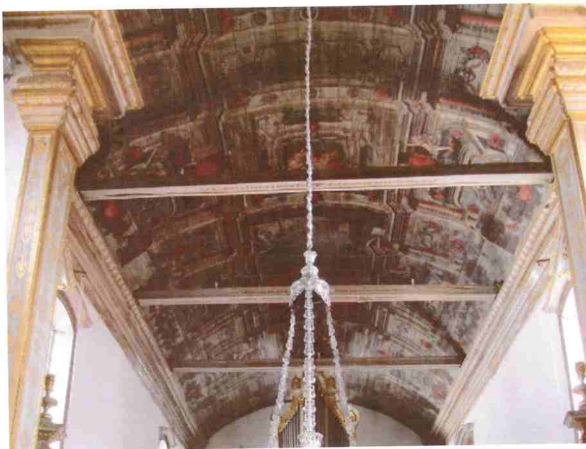
Fig.36 Forro da nave_vista geral
