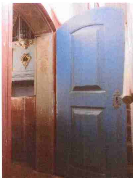
Fig.84 Intradorso da porta de acesso
