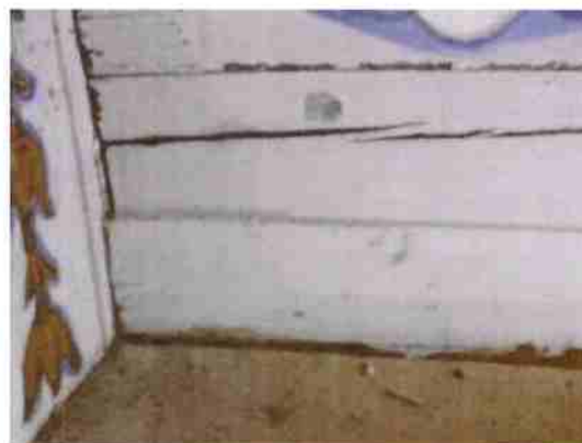
Desajuste e desprendimento de encaixes do tabuado na forração da lateral do camarim
