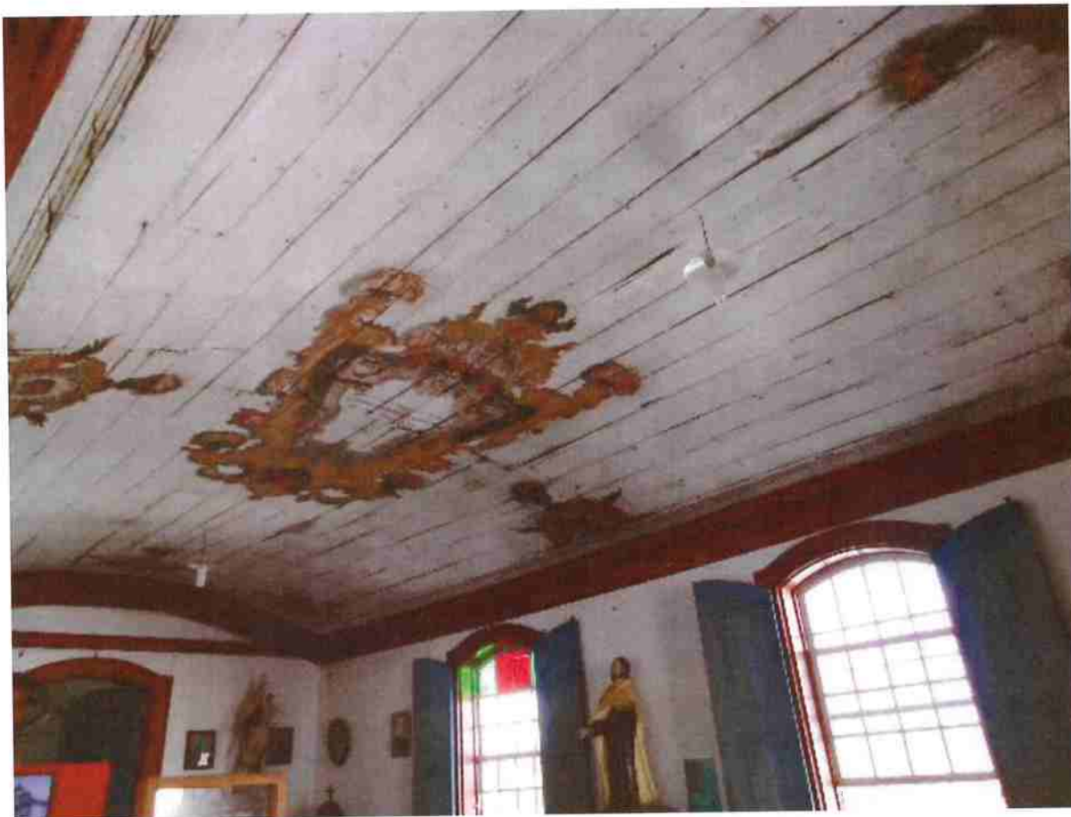
Fig.101 Forro da sacristia
