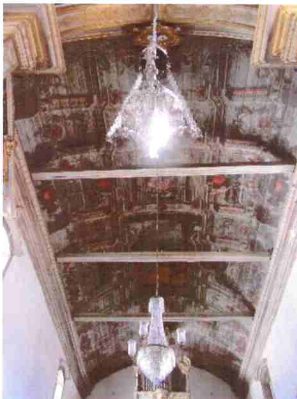
Fig.43 Cimalha e tirantes do forro da nave_vista geral
