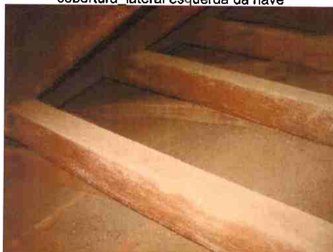
Fig.42 Vistas da parte posterior do forro da nave e sua estrutura de sustentação na cobertura_lateral direita da nave
