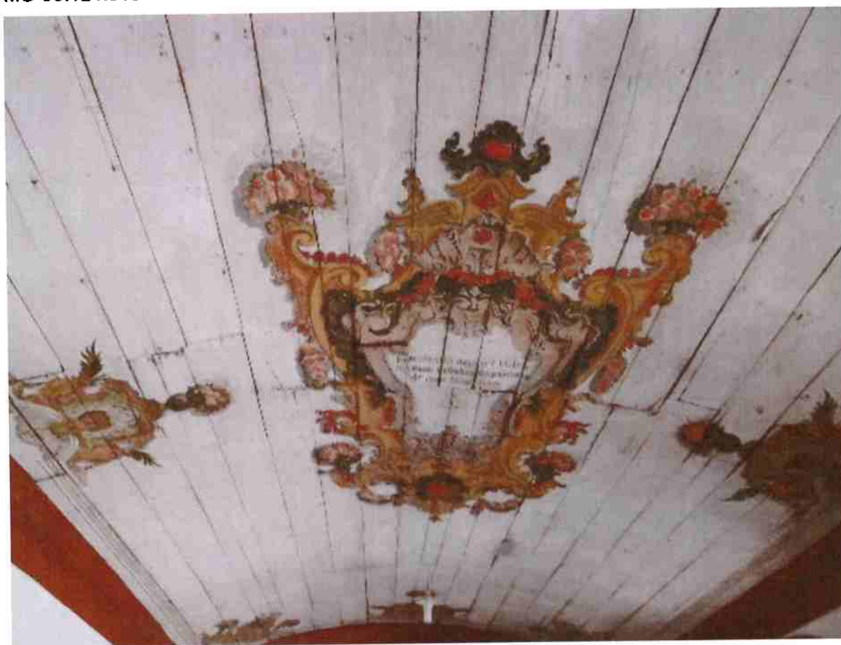
Fig.102 Forro da secretaria paroquial_vista geral do tabuado e medalhão central
