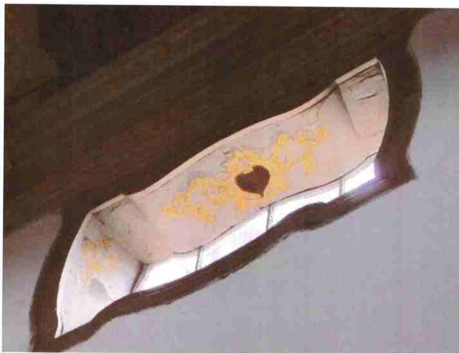
Fig.24 Janela da parede lateral esquerda próxima ao retábulo-mor
