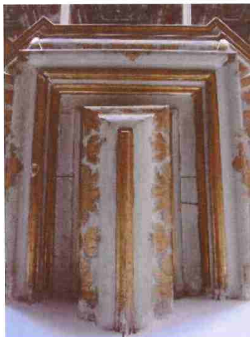
Fig.81 Púlpito_fechamento inferior do console
