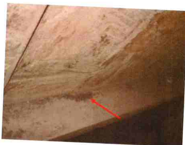
Acúmulo de sujeira e excrementos de insetos. Elemento de sustentação com ataque de insetos xilófagos.
