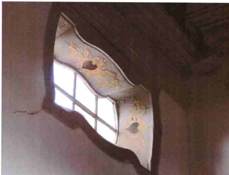
Fig.26 Janela da parede lateral direita próxima ao arco cruzeiro
