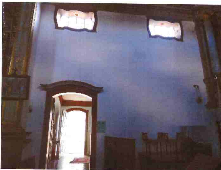
Fig.21 Porta e janelas da parede lateral esquerda da capela-mor
