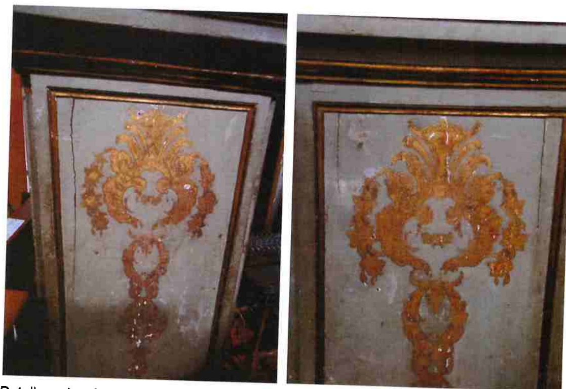
Fig. 12 Degradações na policromia e douramento no arco cruzeiro
