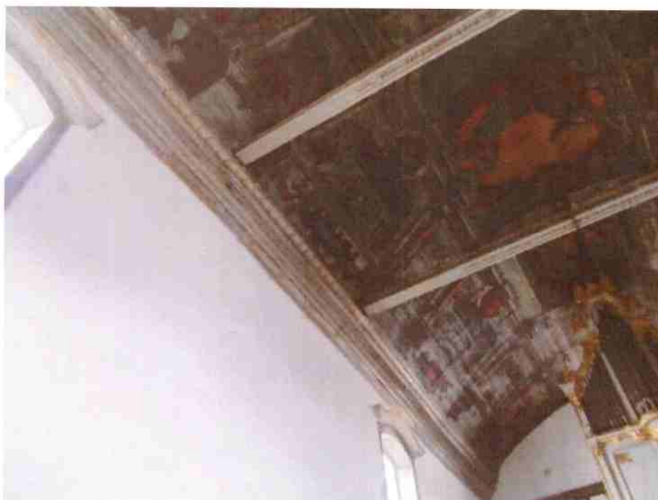
Fig.45 Cimalha e tirantes do forro da nave_vista do lado esquerdo e do lado direito
