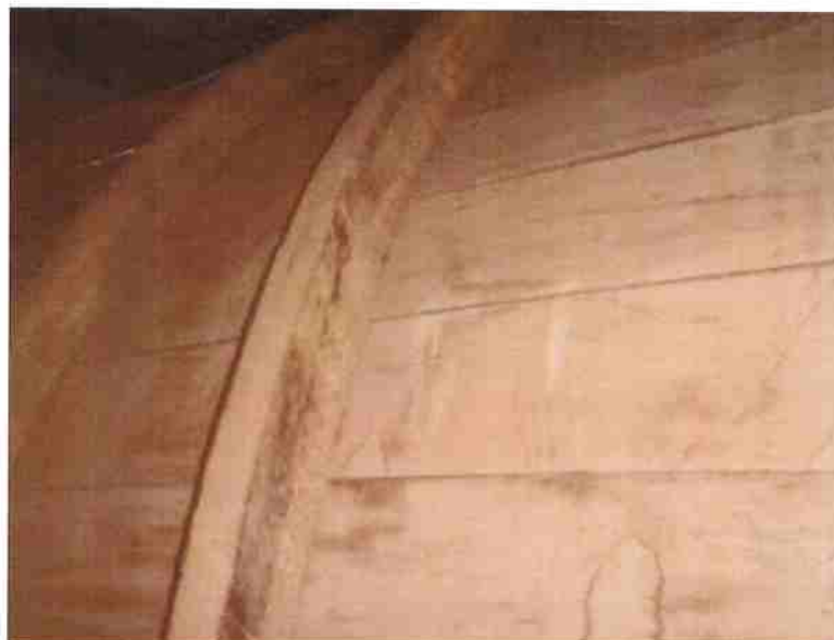
Fig.19 Estrutura posterior do forro do camarim
