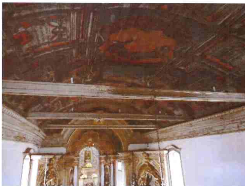
Fig.44 Tirantes do forro da nave_vista lateral, do coro
