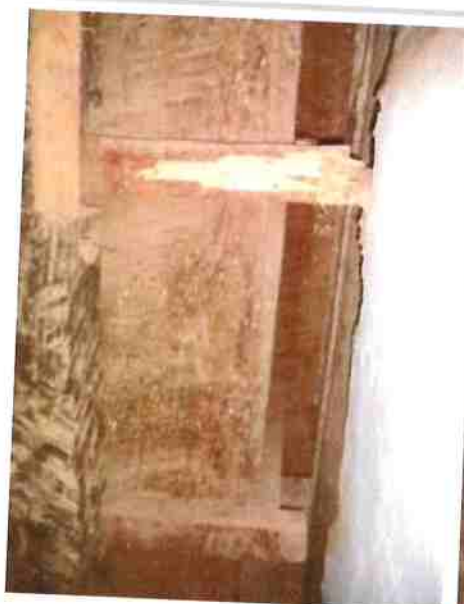
Acúmulo de sujeira e excrementos de insetos. Elemento de sustentação com ataque de insetos xilófagos.
