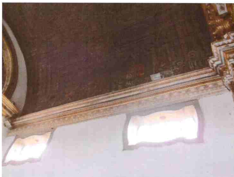
Fig.23 Janelas da parede lateral direita da capela-mor
