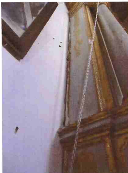
Fig.33 Revestimento lateral da pilastra do arco na lateral esquerda
