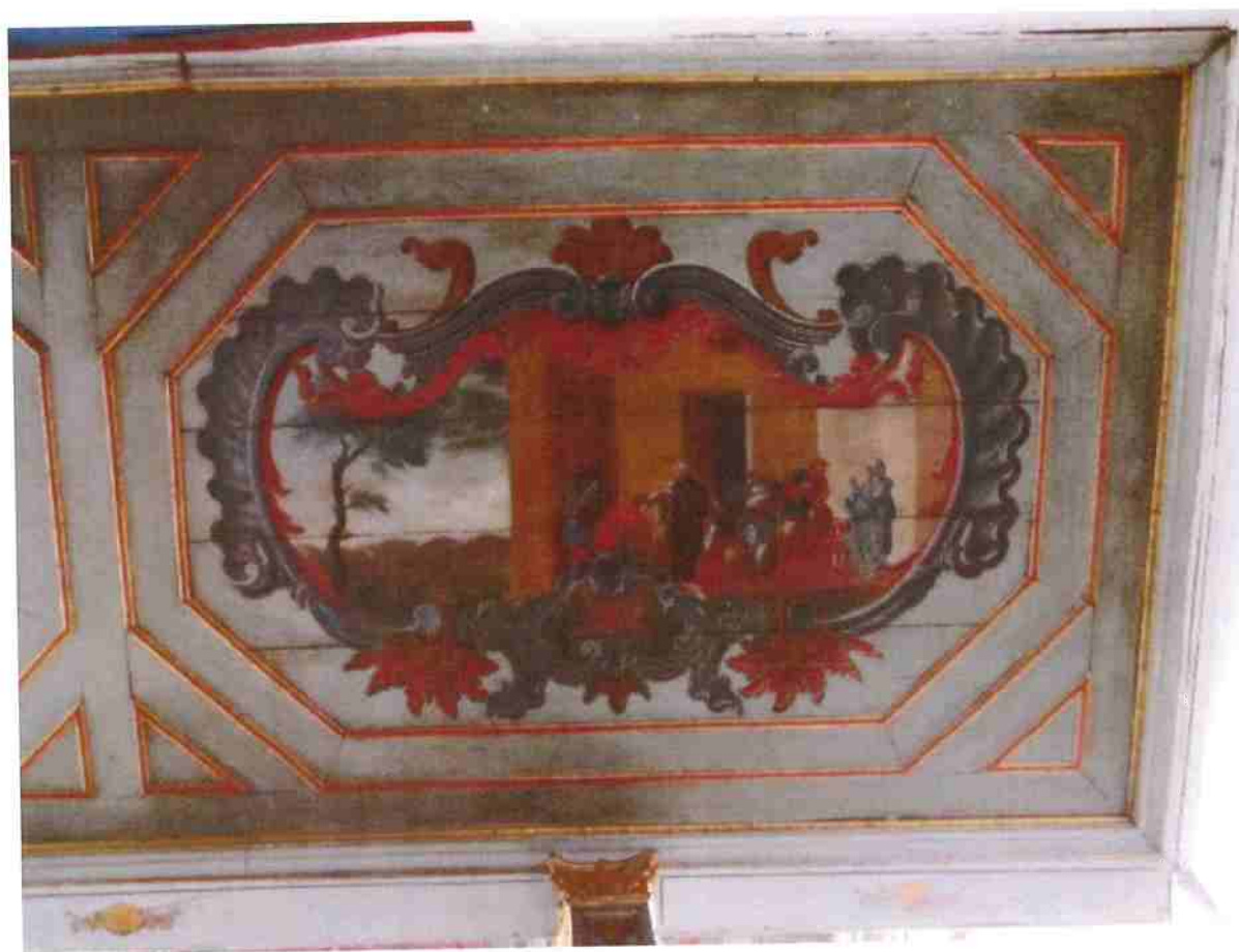
Fig.98 Forro do átrio_painel do lado direito
