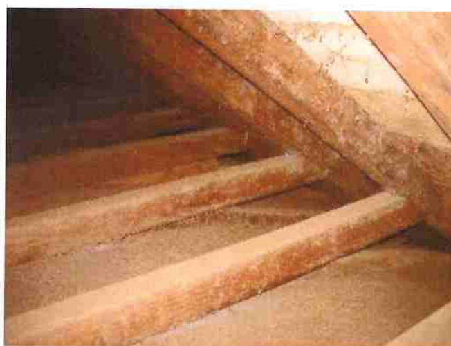
Fig.41 Vistas da parte posterior do forro da nave e sua estrutura de sustentação na cobertura_lateral esquerda da nave
