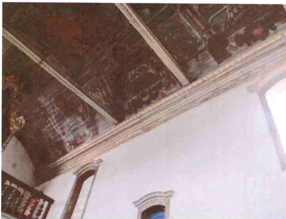
Cimalha e tirantes do forro da nave_vista do lado esquerdo
