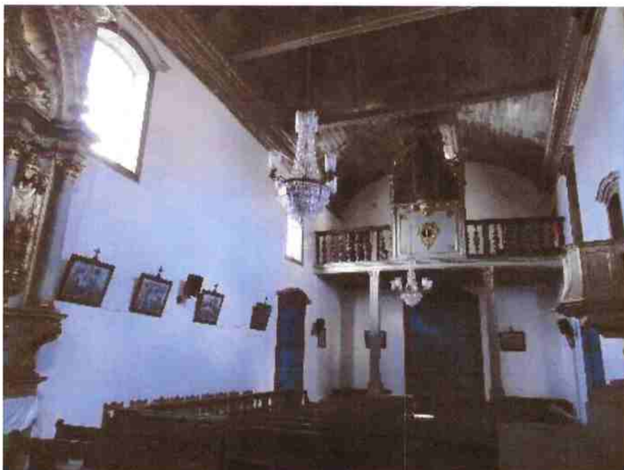
Fig.86 Parede direita da nave_vista geral
