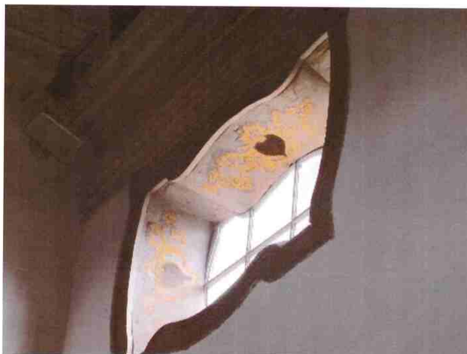
Fig.25 Janela da parede lateral esquerda próxima ao arco cruzeiro
