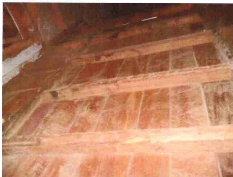
Fig.20 Tabuado novo no revestimento lateral na parte posterior do retábulo-mor
