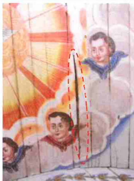
Desajuste e desprendimento de encaixes do tabuado na forração da lateral do camarim
