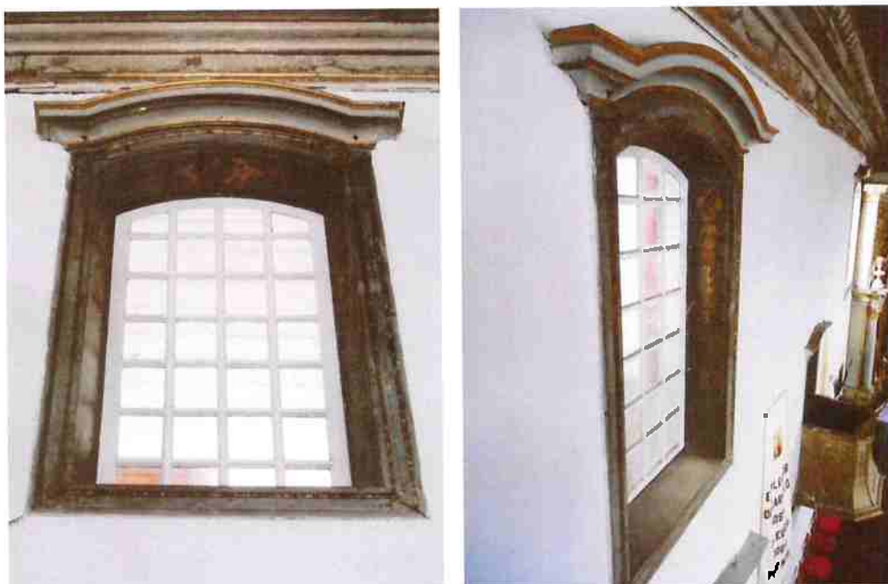
Policromia ressecada, com abrasões, perdas e manchas.
