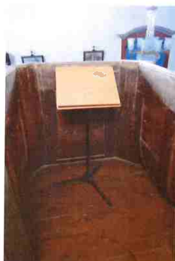
Desajustes e fresta entre tábuas de forração, desprendimento na fixação das molduras e furo para passagem de fiação.
