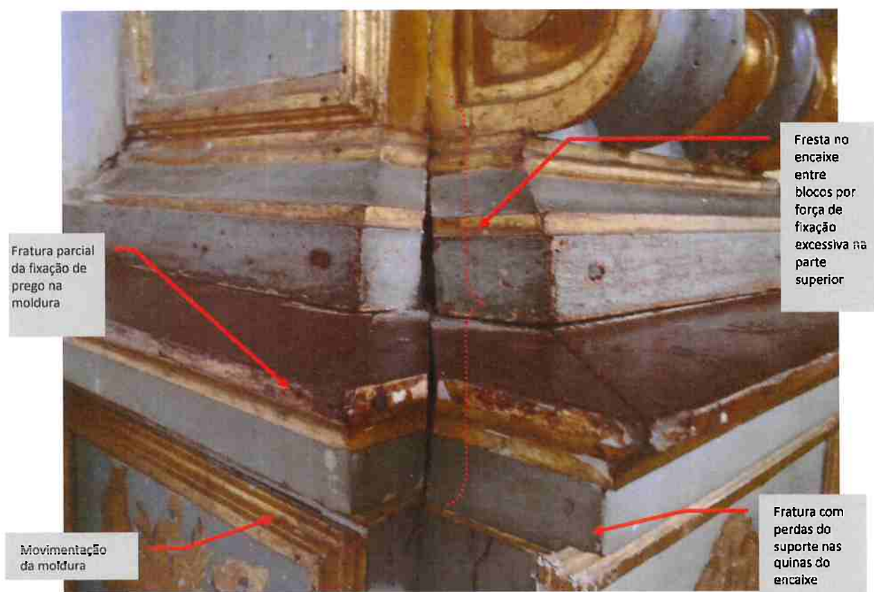
Fig. 16 Degradações do suporte no retábulo colateral de Santo Elias (lado esquerdo)
