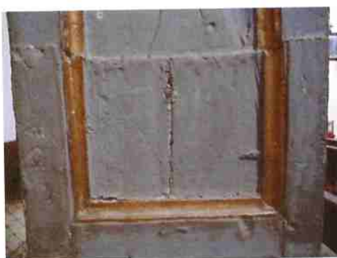
Intervenção anterior inadequada e registro da camada de policromia subjacente.
