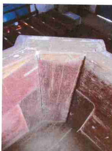
Desajustes e fresta entre tábuas de forração, desprendimento na fixação das molduras e furo para passagem de fiação.
