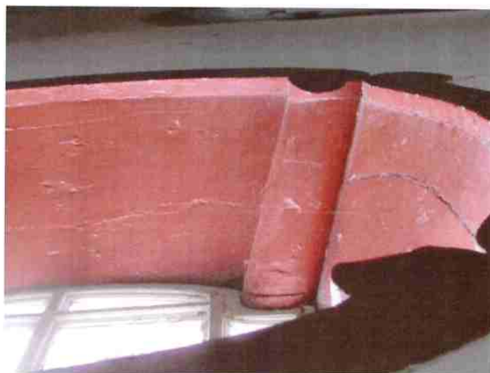
Detalhe da parte superior da moldura com perdas pontuais do suporte, fraturas longitudinais que acompanham o veio da madeira e irregularidades.
