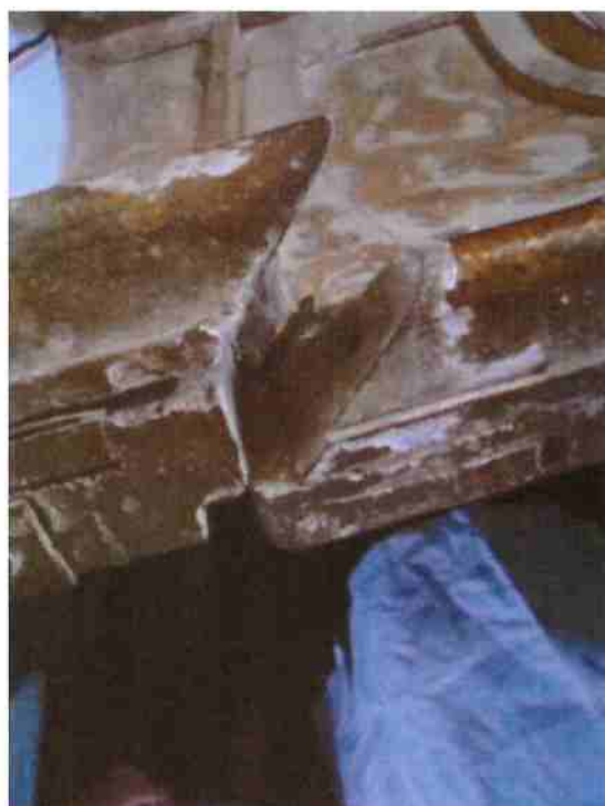
Desajuste entre blocos construtivos e galerias pelo ataque de insetos xilófagos.
