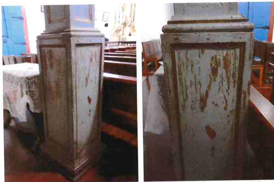
Pequenas perdas do suporte, principalmente nas quinas.
