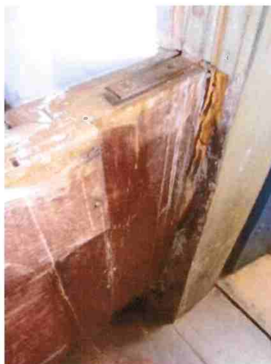
Desajuste entre blocos construtivos e galerias pelo ataque de insetos xilófagos.
