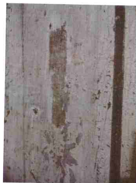
Detalhe de remoção com decapante industrial em gel
