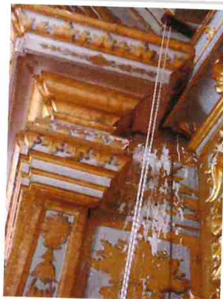
Abrasão e materiais incrustados na parte superior do painel lateral do arco, ao lado retábulo colateral direito
