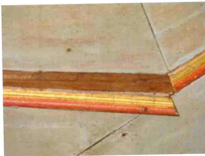
Detalhe do friso deslocado da posição original
