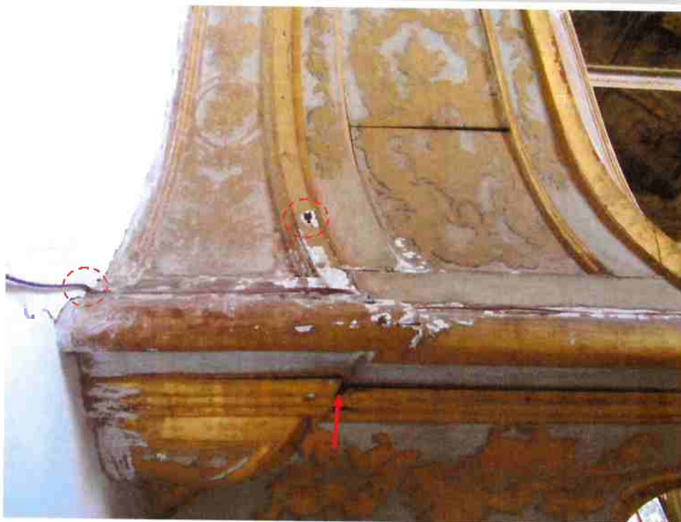
Desajustes e fresta entre tábuas de forração, desprendimento na fixação das molduras e furo para passagem de fiação.
