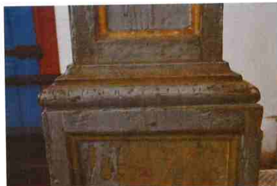
Intervenção anterior inadequada e registro da camada de policromia subjacente.
