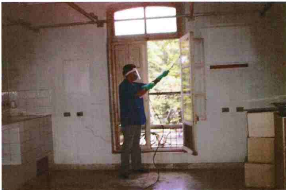
Procedimento para pulverização das esquadrias e janelas. FONTE: Azevedo Júnior, 2015.
