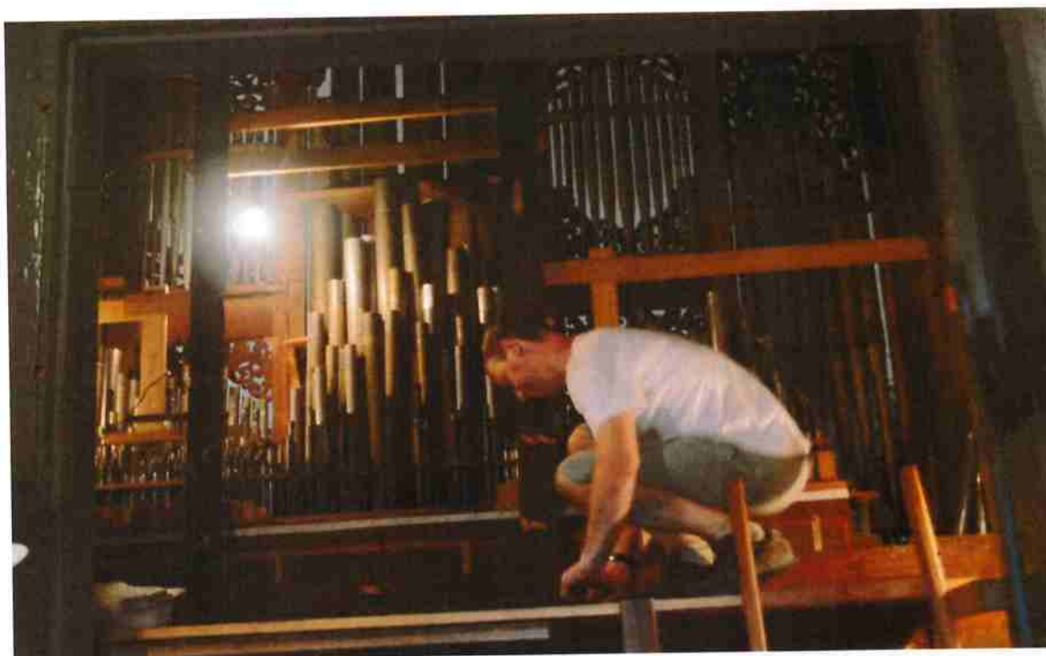
Figura 6. Classificação e ordenação dos tubos durante a desmontagem
