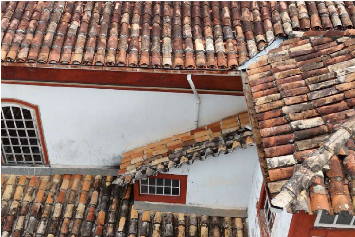
Vista descidas e calhas da fachada Lateral esquerda
