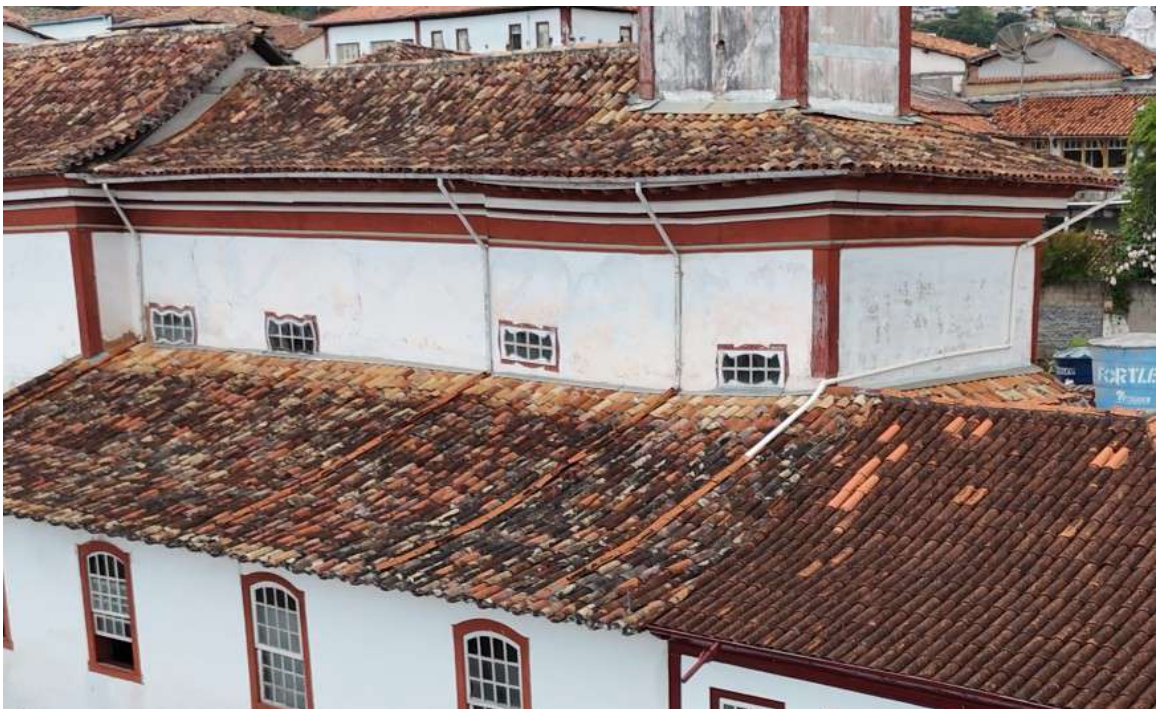
Vista sistema pluvial fachada lateral direita e alinhamento posterior
