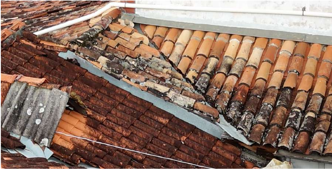
Vista rufo e rincão na cobertura nível 1º pavimento
