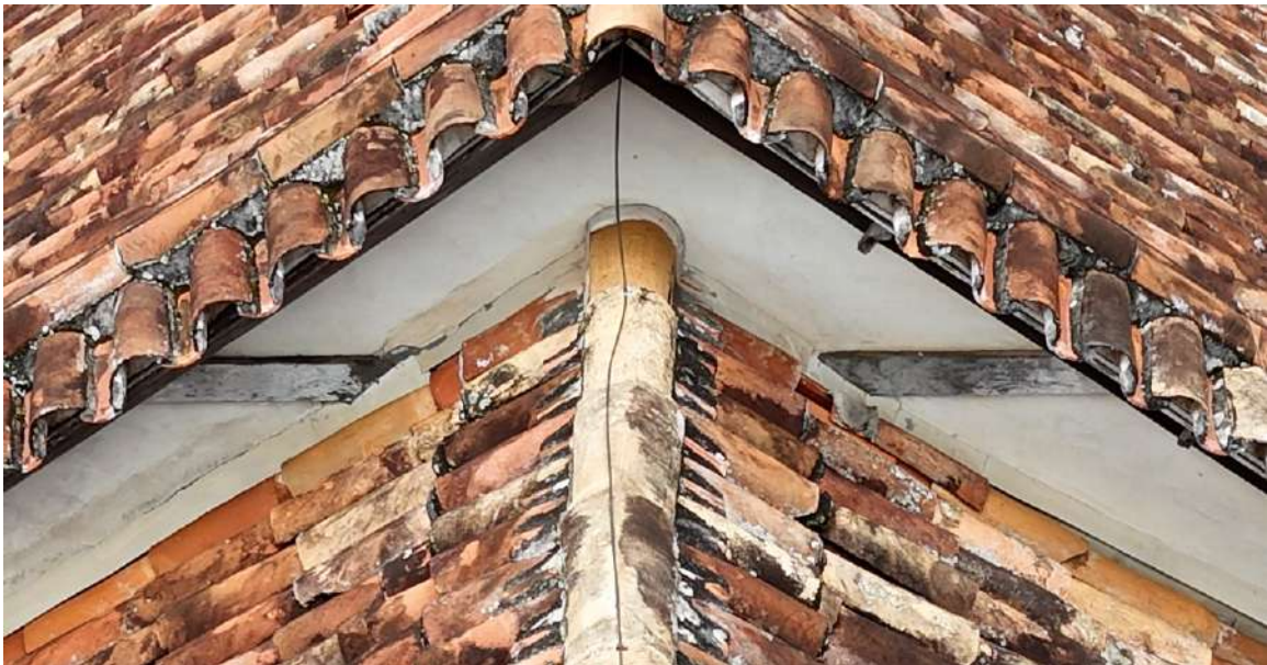
Detalhe arremate empina na Cumeeira da capela Môr
