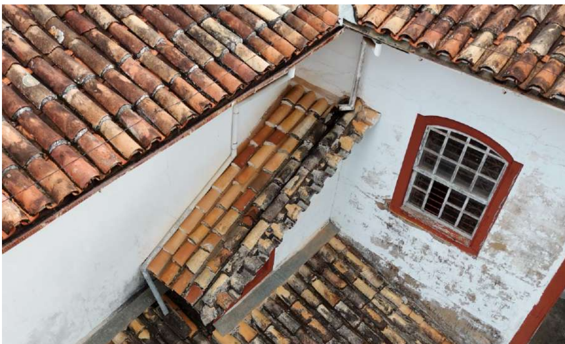
Vista descidas e calhas da fachada Lateral esquerda
