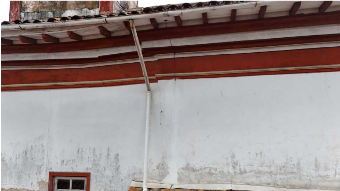
Detalhe ponto de descida no alinhamento da Capela Môr
