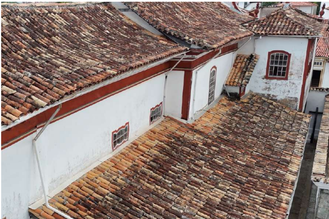
Vista alinhamento lateral esquerdo
