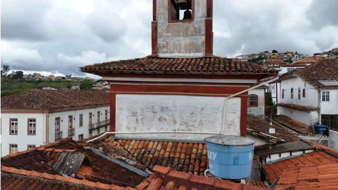
Vista coberturas na posterior
