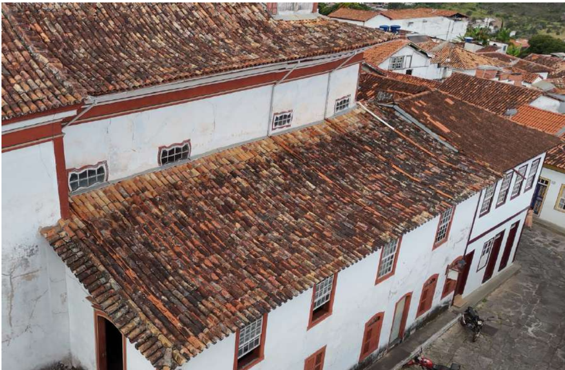
Vista sistema pluvial fachada lateral direita e alinhamento posterior
