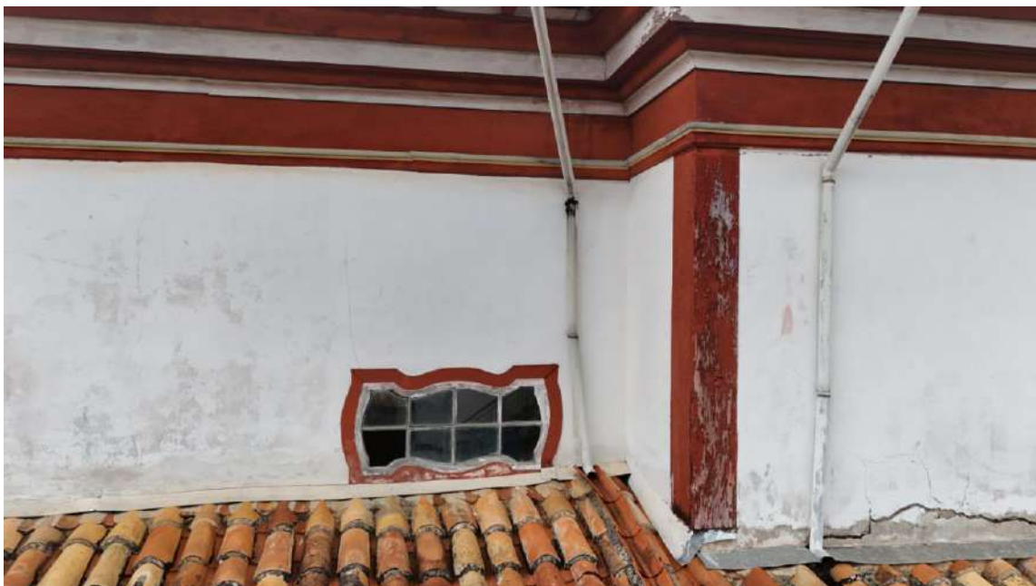
Detalhe descidas no alinhamento encontro Capela Mór e Nave
