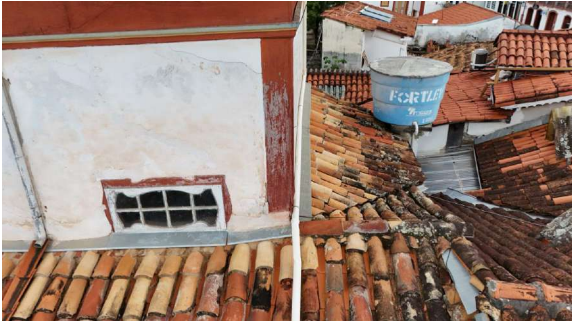
Vista cobertura posterior
