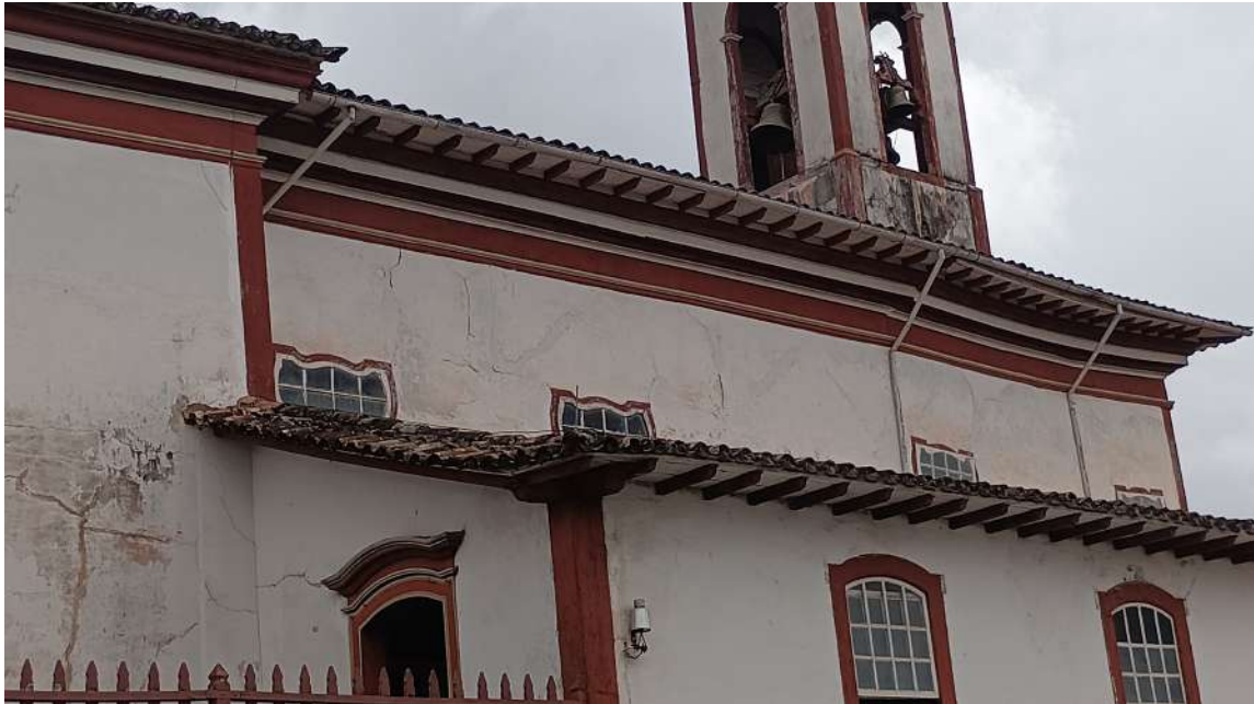
Vista sistema pluvial fachada lateral direita e alinhamento posterior
