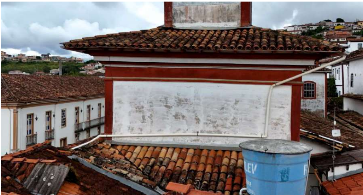
Vista sistema pluvial implantado na posterior e rufo
