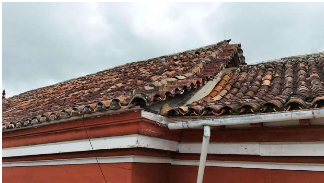
Detalhe ponto de coleta e descida no encontro Capela Mór e Nave
