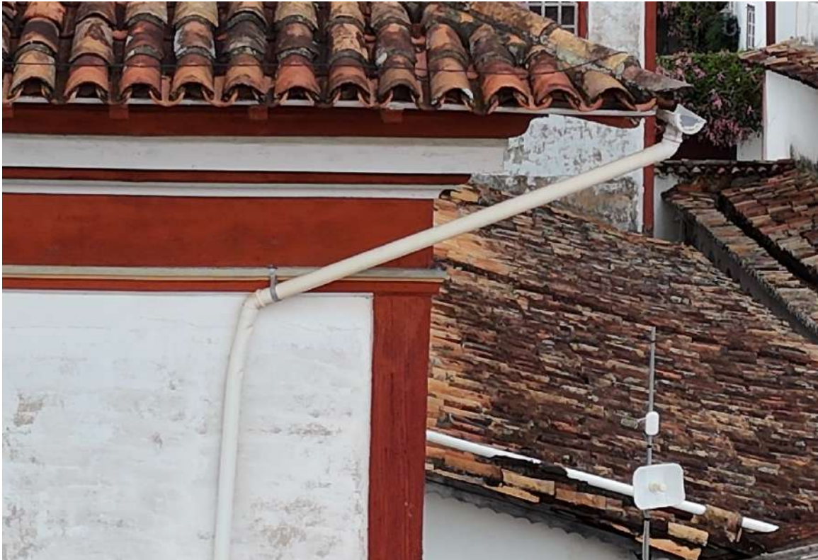
Detalhe ponto de ligação coleta e condução
