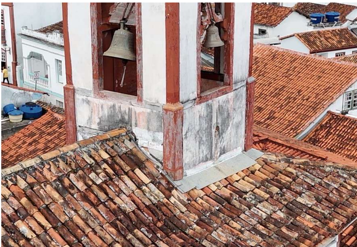
Vista arremate do rufo na Torre
