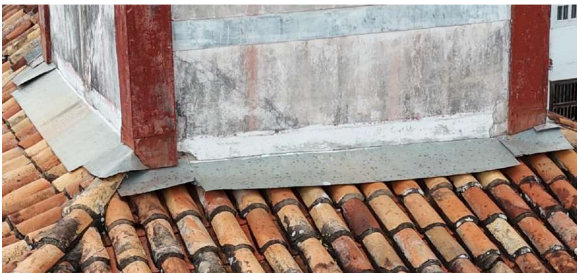
Vista arremate do rufo na Torre, alinhamento lateral direito
