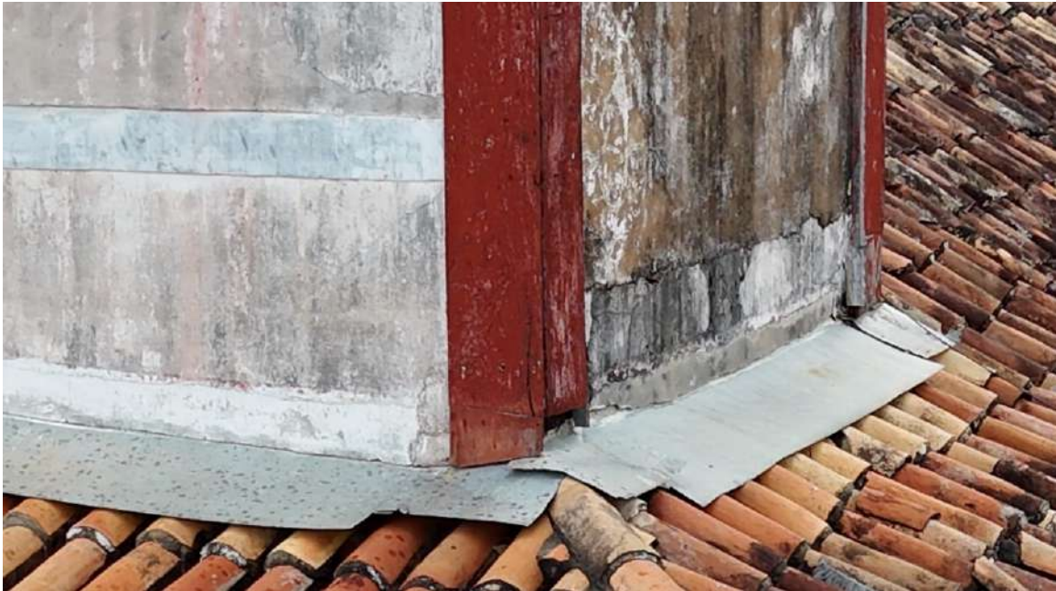
Vista arremate do rufo na Torre, alinhamento posterior
