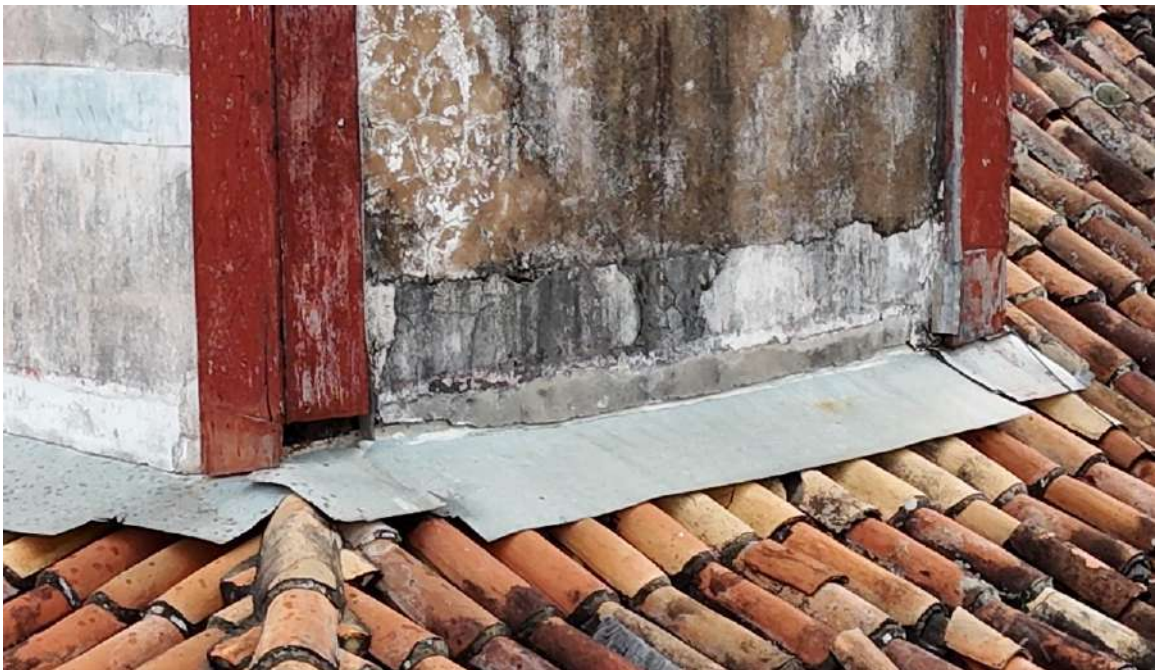
Vista arremate do rufo na Torre, alinhamento posterior
