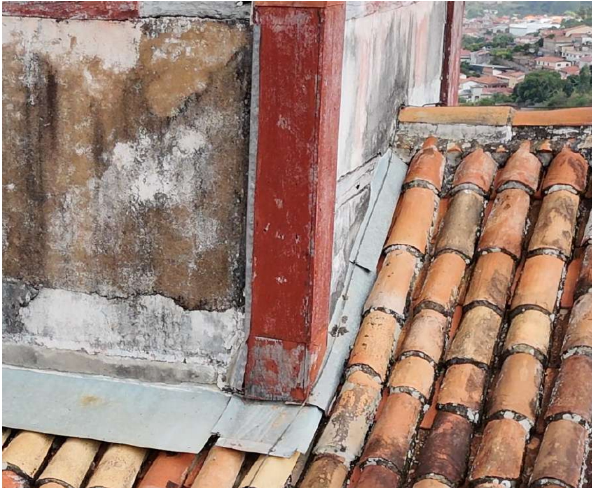
Vista arremate do rufo na Torre, alinhamento principal
