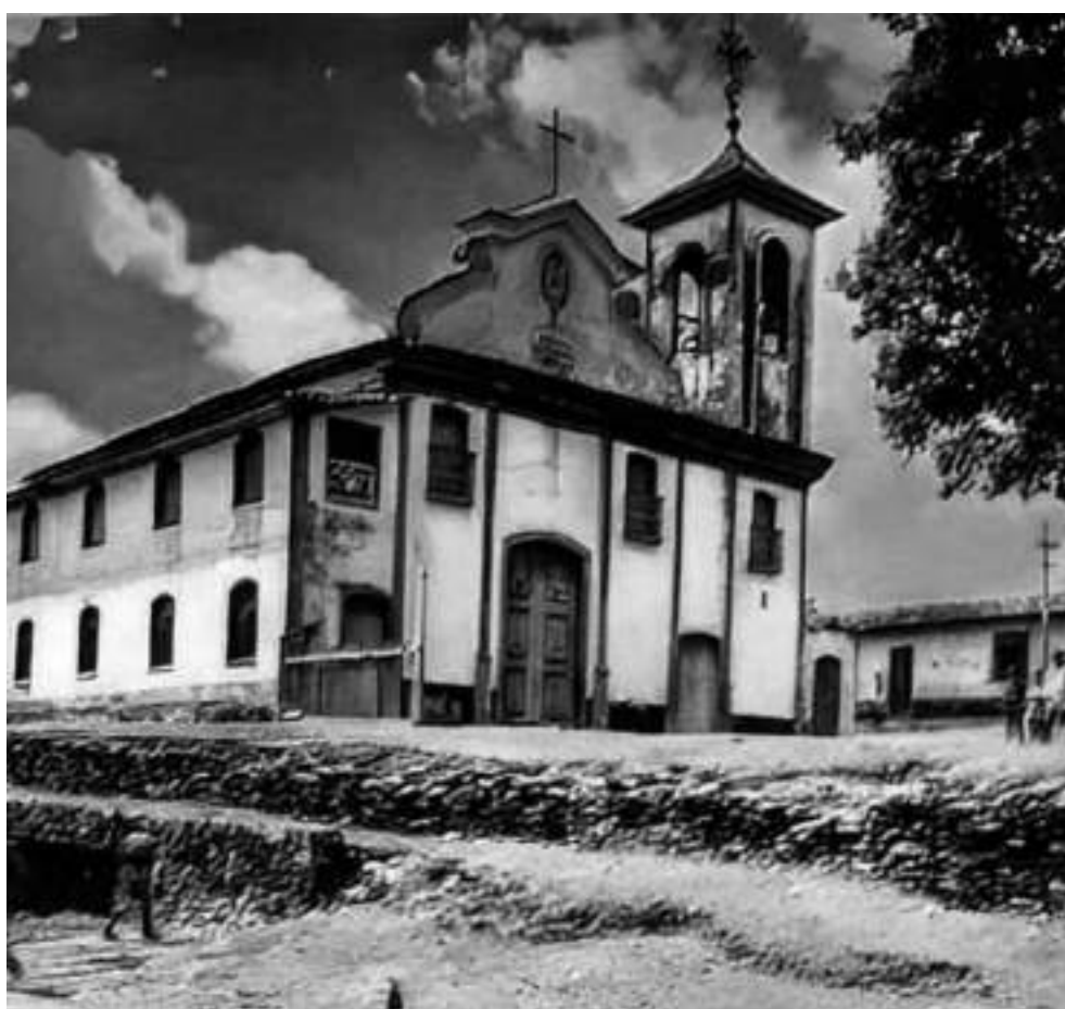
Imagem 03 - Igreja de Nossa Senhora do Rosário dos Homens Pretos vista da frente.
