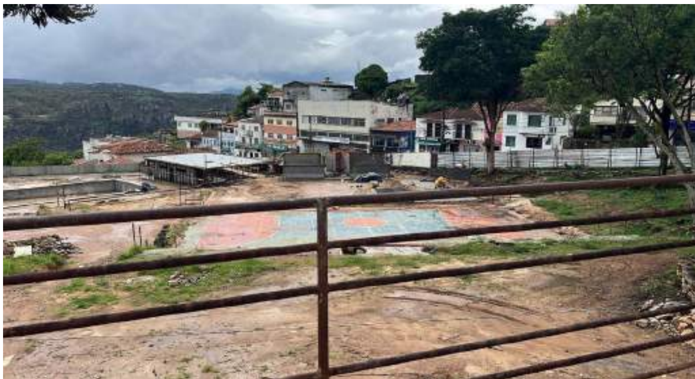
Figura 01: Foto da Edificação Existente
