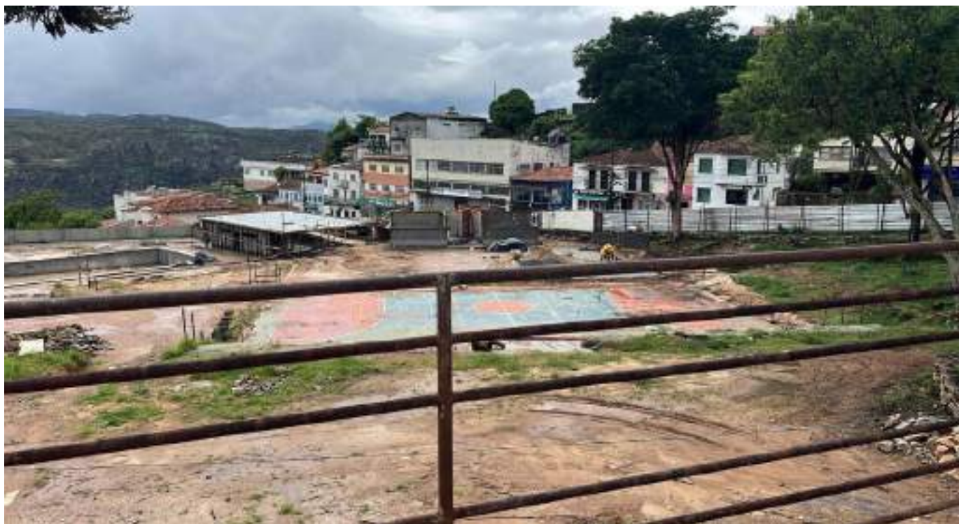
Figura 01: Foto da Edificação Existente
