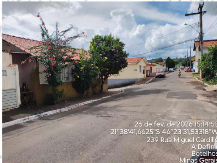
Figura 1- Início do recapeamento e drenagem na Rua José de Andrade
