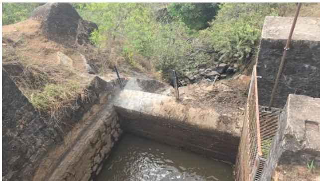
Foto do local de barramento e entrada da água para a captação da ETA I.
