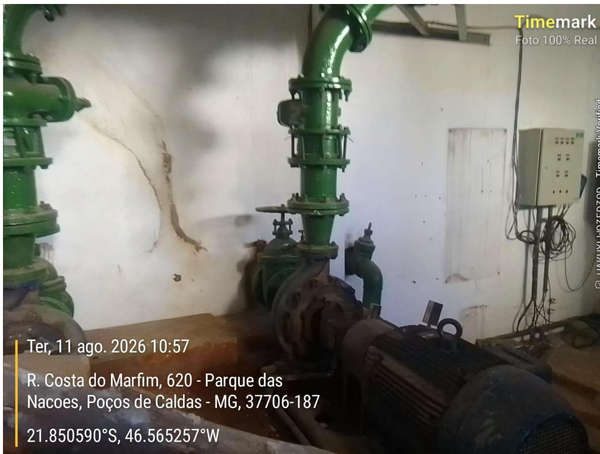
Foto 02 – Vista da casa de bombas da ETA IV – Data: 11/08/2026
