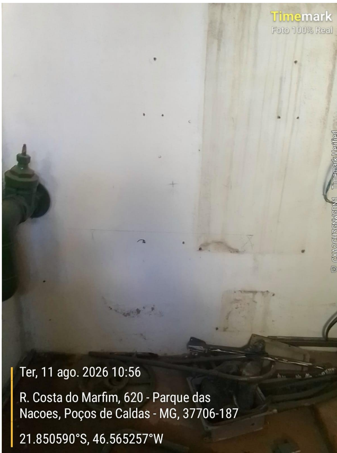
Foto 03 – Foto do local do furo 1 da casa de bombas ETA IV - Data: 11/08/2026
