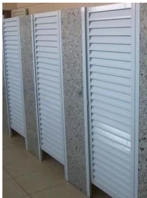
Figura 8 – Modelo de porta padrão alumínio lambril gold para sanitários fixado em divisórias de granito
