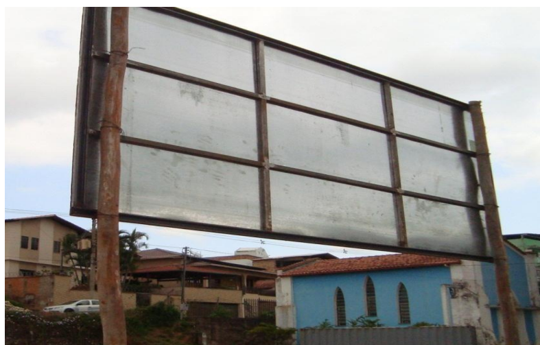
Figura 1 - Fundo e estrutura da placa de identificação da obra
