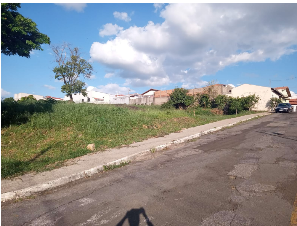
Figura 4: Vista de onde encontra-se a calçada executada (Rua do Ouro)
