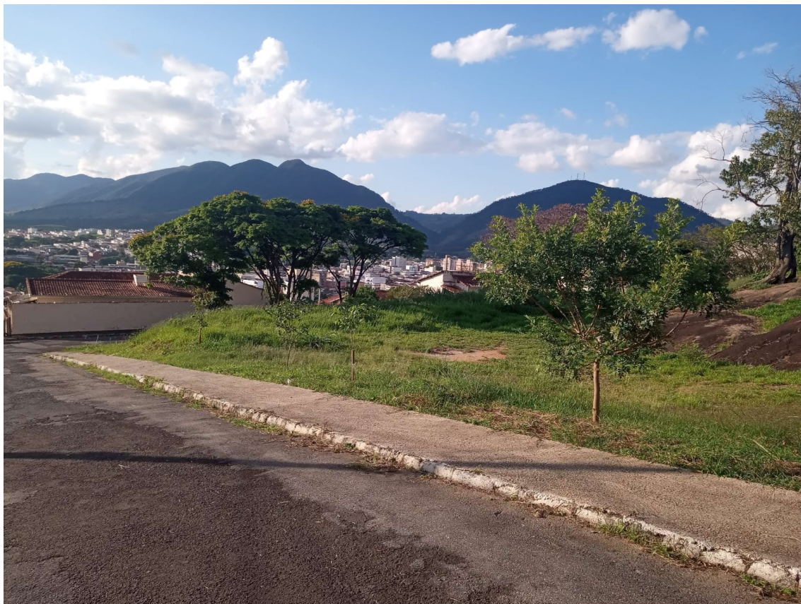
Figura 5: Vista de onde encontra-se a calçada executada (Rua do Cobre)
