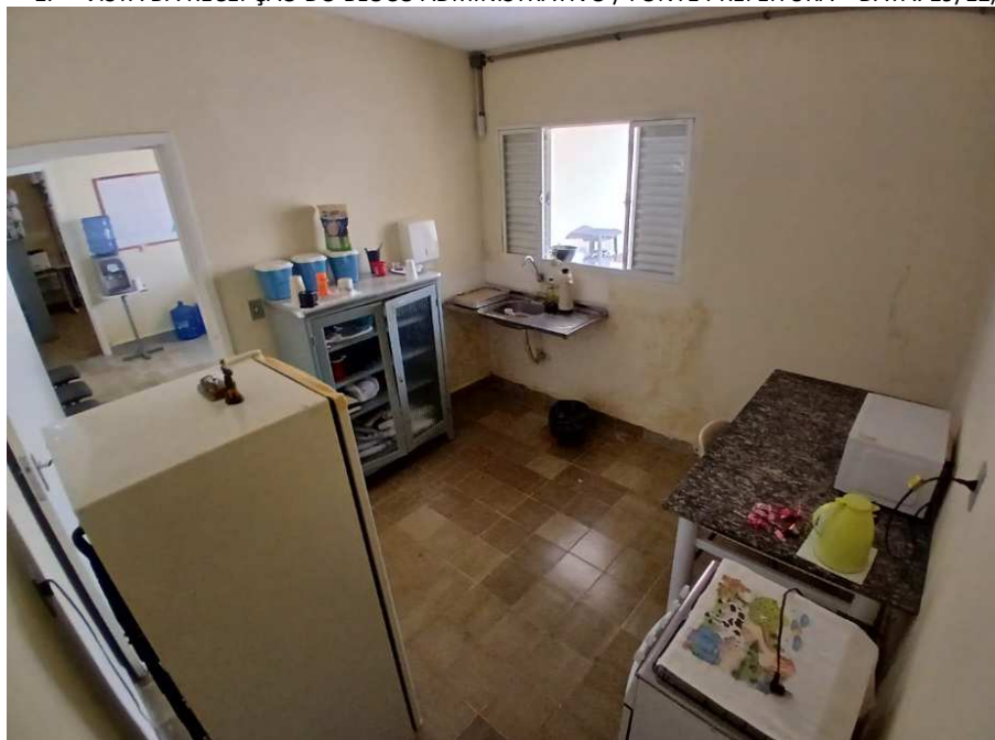
2. VISTA DA COZINHA DO BLOCO ADMINISTRATIVO / FONTE PREFEITURA – DATA: 19/12/25
