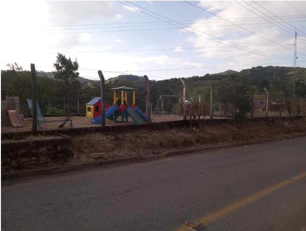
Figura 3: Vista do local onde será executado o muro de arrimo e muro de fechamento (divisa) da Escola Municipal Luiz Augusto de Melo
