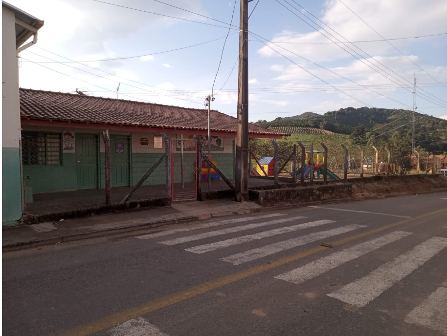
Figura 1: Vista do local onde será executado o muro de arrimo e muro de fechamento (divisa) da Escola Municipal Luiz Augusto de Melo
