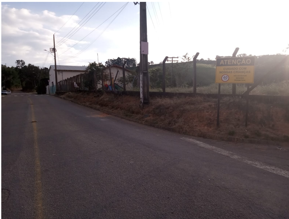
Figura 2: Vista do local onde será executado o muro de arrimo e muro de fechamento (divisa) da Escola Municipal Luiz Augusto de Melo
