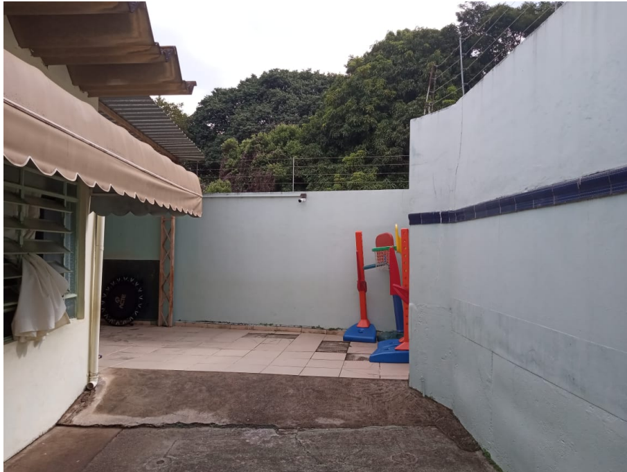
Figura 1: Local em que será executado a Sala Multissensorial
