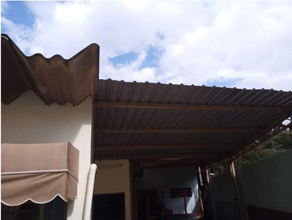
Figura 5: Local em que será executado a Sala Multissensorial
