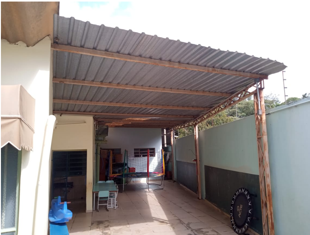
Figura 4: Local em que será executado a Sala Multissensorial
