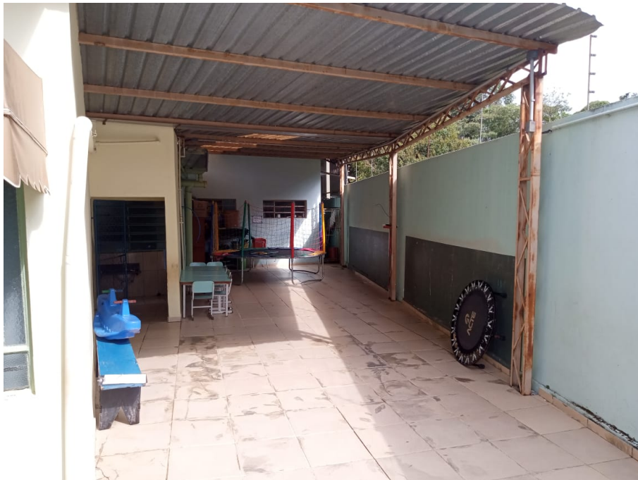
Figura 2: Local em que será executado a Sala Multissensorial
