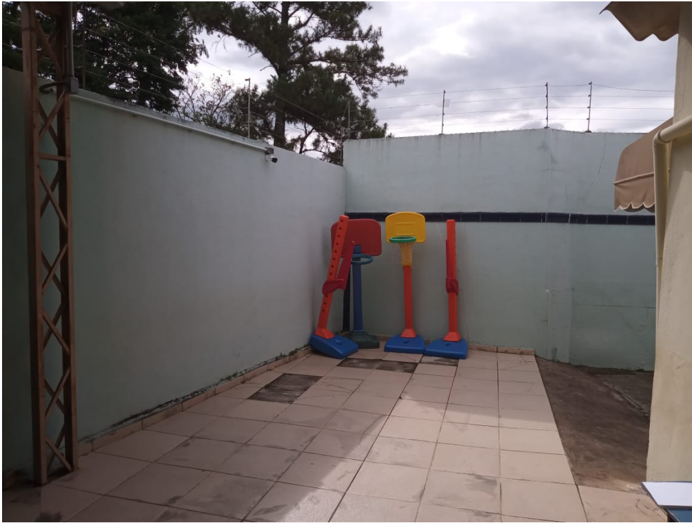
Figura 3: Local em que será executado a Sala Multissensorial
