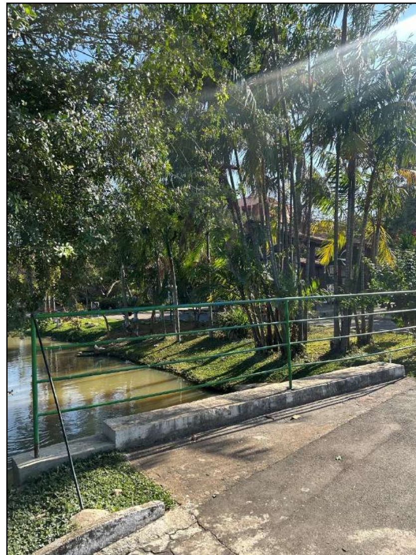
Foto 26 – Guarda Corpo existente
