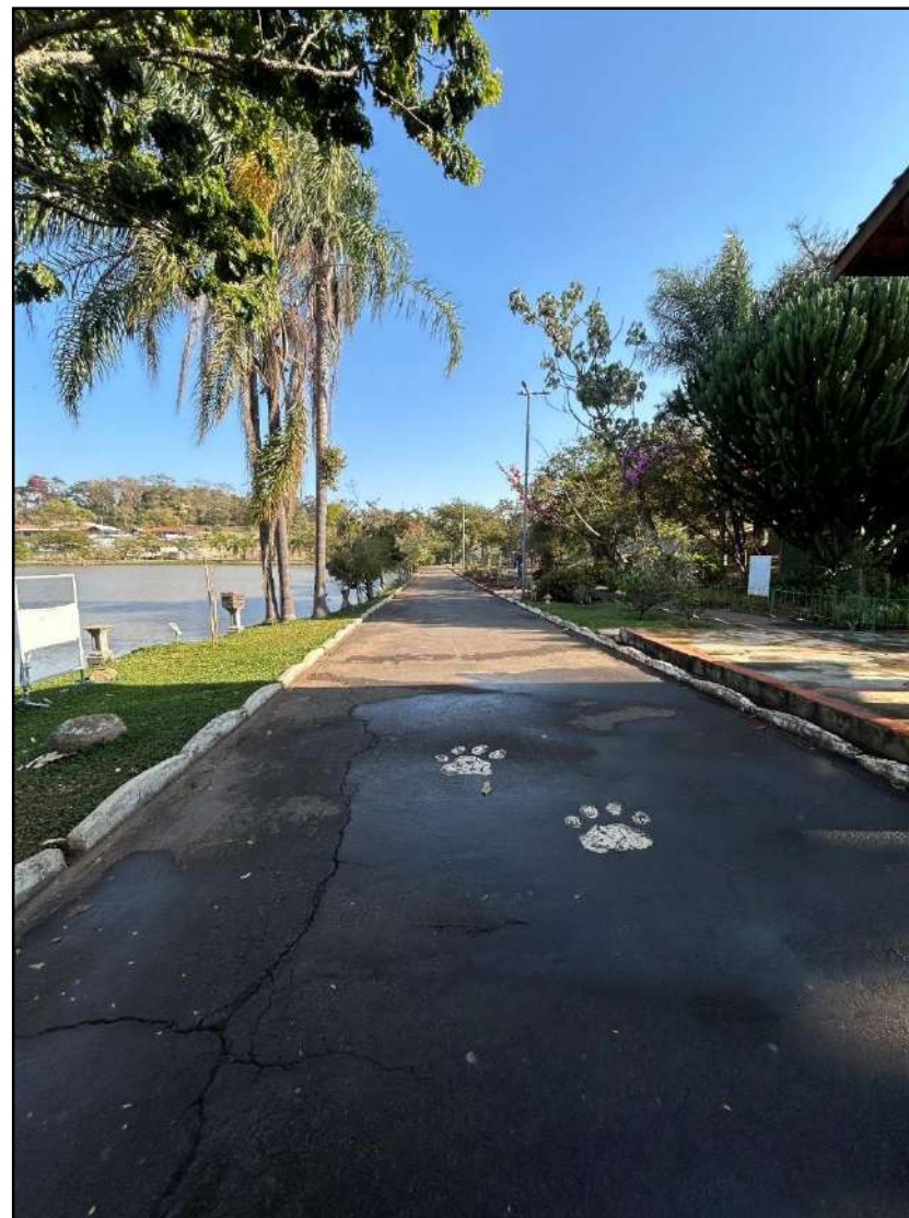
Foto 10 – Caminho interno pavimentado
