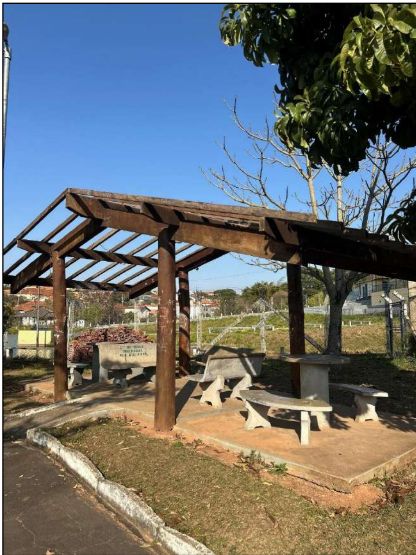
Foto 23 – Recuperação do telhado do quiosque: Presença de desnível no terreno com canaleta de drenagem lateral; parede externa ao fundo com pontos de reparo no revestimento e sinais de umidade junto à base.
