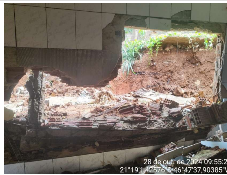
Descrição: PAREDE DA COZINHA DA CASA ONDE O MURO CAIU NO DIA DA CHUVA – 28/10/2024
