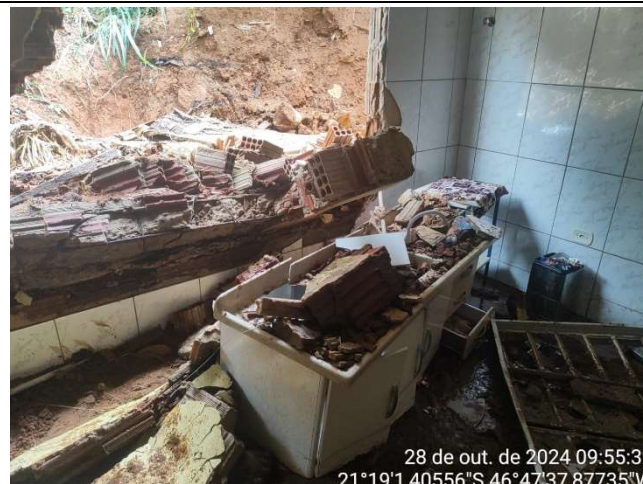
Descrição: PAREDE DA COZINHA DA CASA ONDE O MURO CAIU NO DIA DA CHUVA – 28/10/2024
