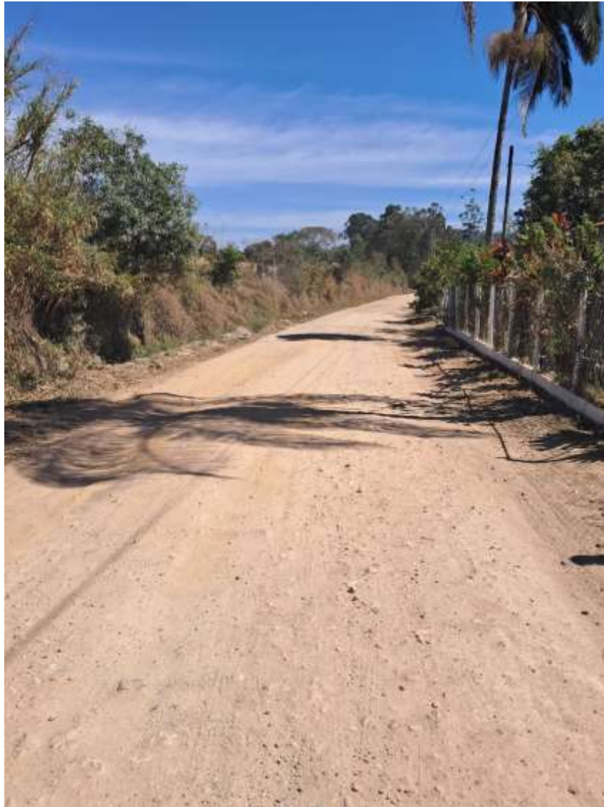
FOTO 04 – TRECHO BAIRRO PENHA AO BAIRRO BREJÃO
