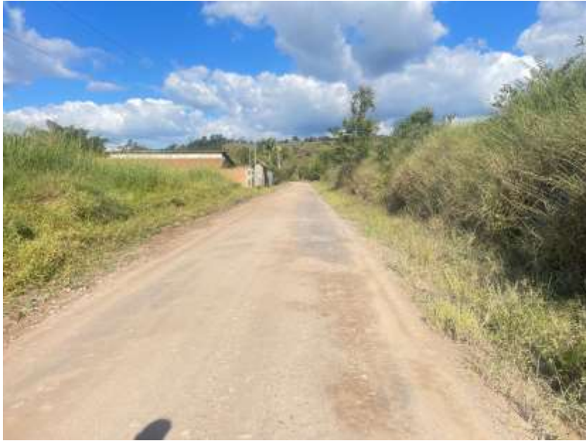
FOTO 02 – TRECHO BAIRRO PENHA AO BAIRRO BREJÃO
