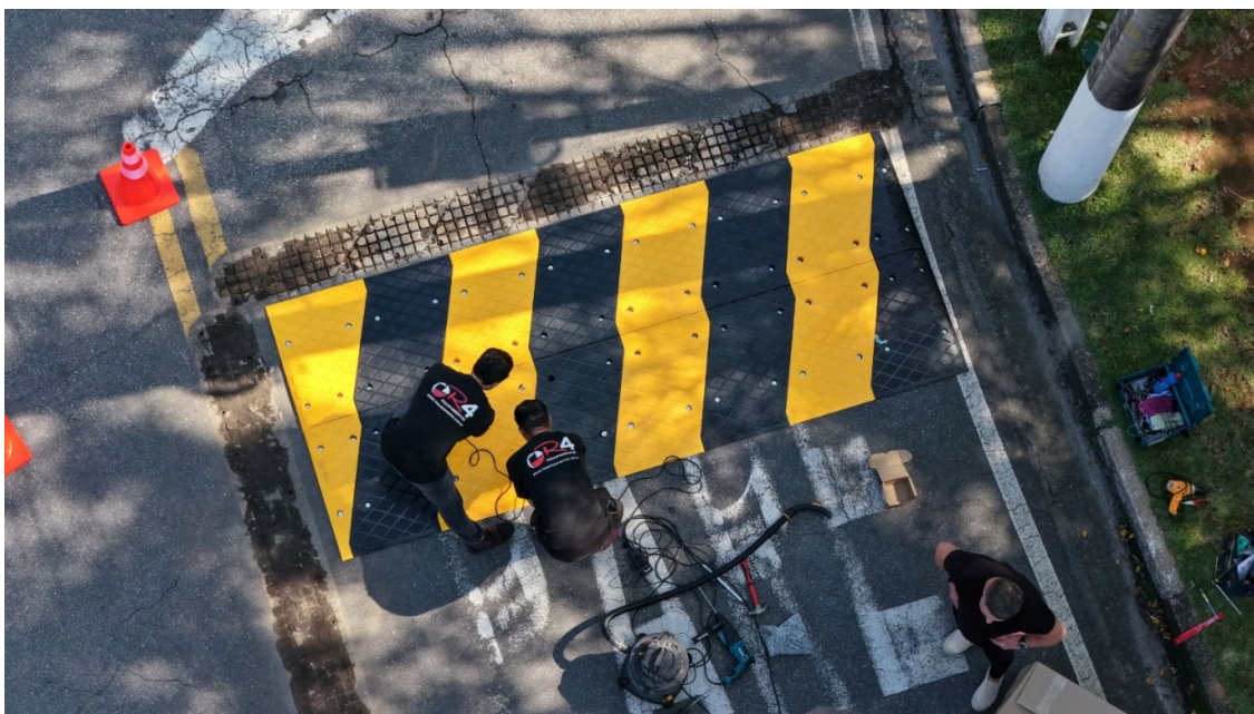
Figura: Montagem de lombada modular.
