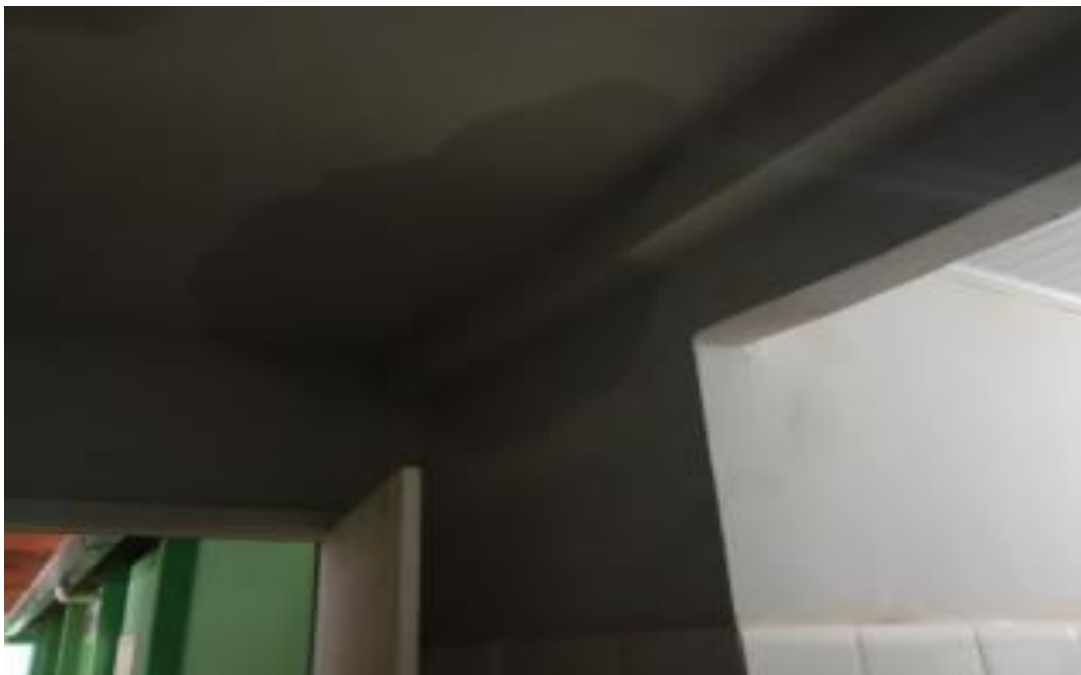
FOTOS 04 – INFILTRAÇÃO DEVIDO PROBLEMAS TELHADO.
