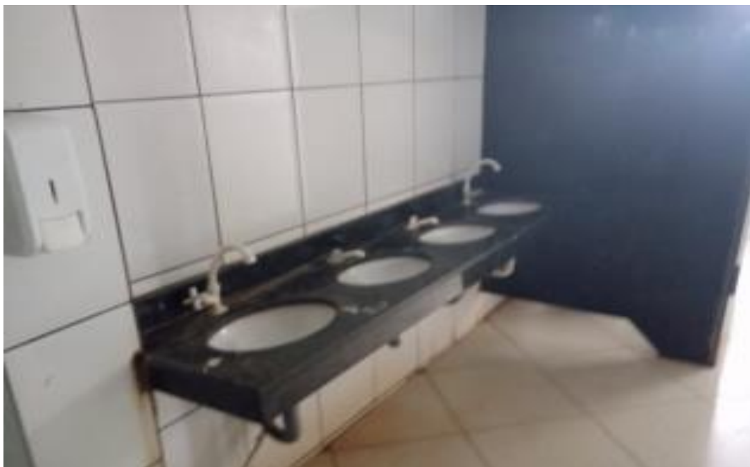
FOTOS 14 – TORNEIRAS E SIFÕES A SUBSTITUIR.
