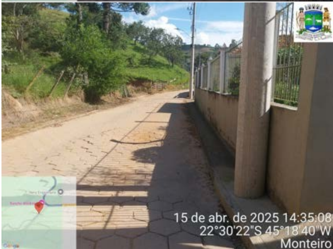
Monteiro- Trecho 9 (duas fotos acima)- Estacas 7 e Estaca 8
