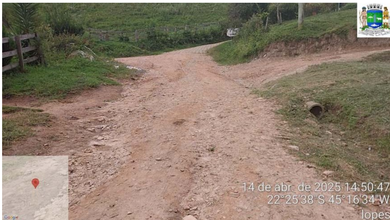
Lopes- Trecho 8- Estaca 2- Estaca 3
