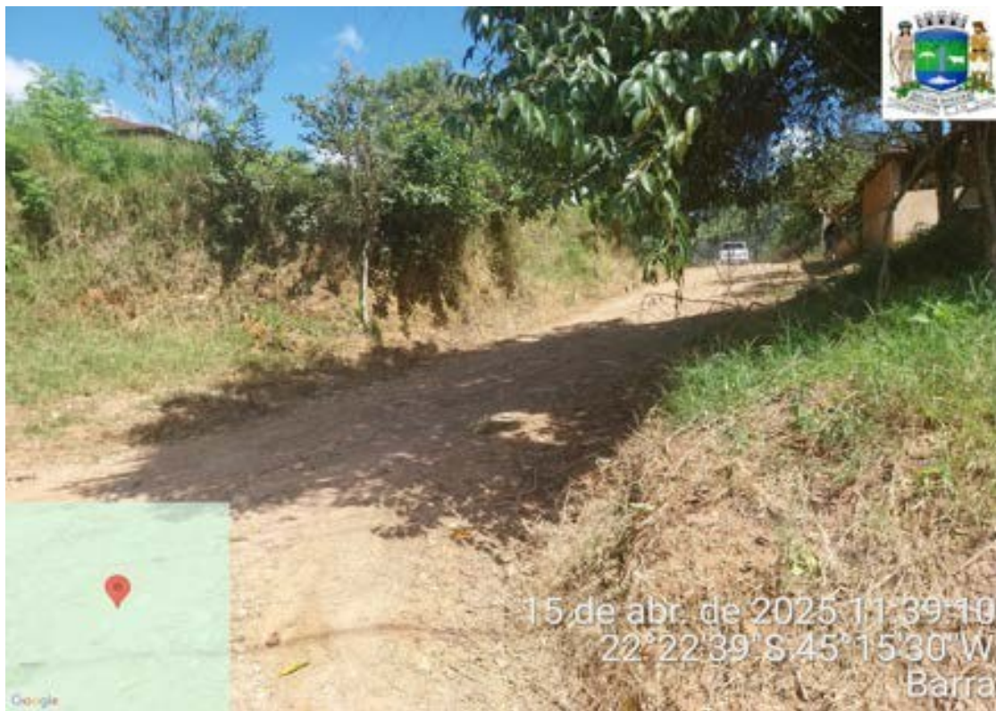
Barra – Trecho 2- Estaca 3 até Estaca 4
