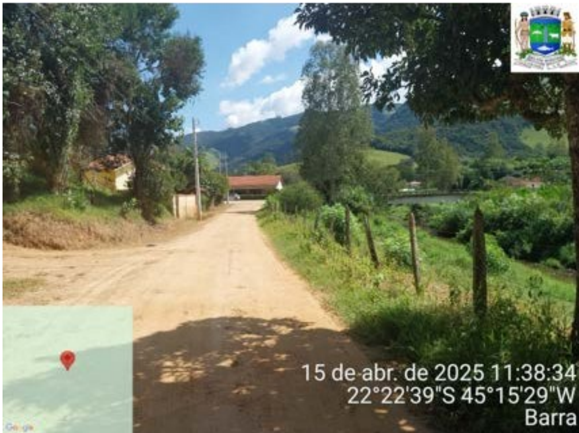
Barra- Trecho 1- Estaca 1 Até Estaca 3
