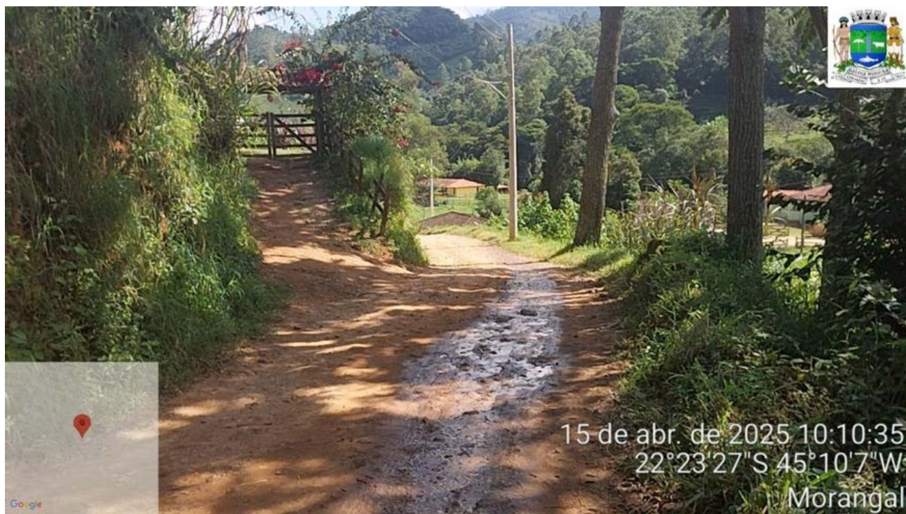
Morangal- Trecho 3- Estaca 5 até Estaca 4
