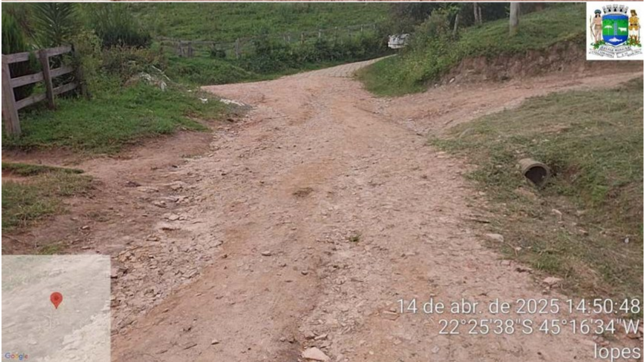
Trecho 8- Lopes (2 fotos acima) Entre Estaca 3 e Estaca 4
