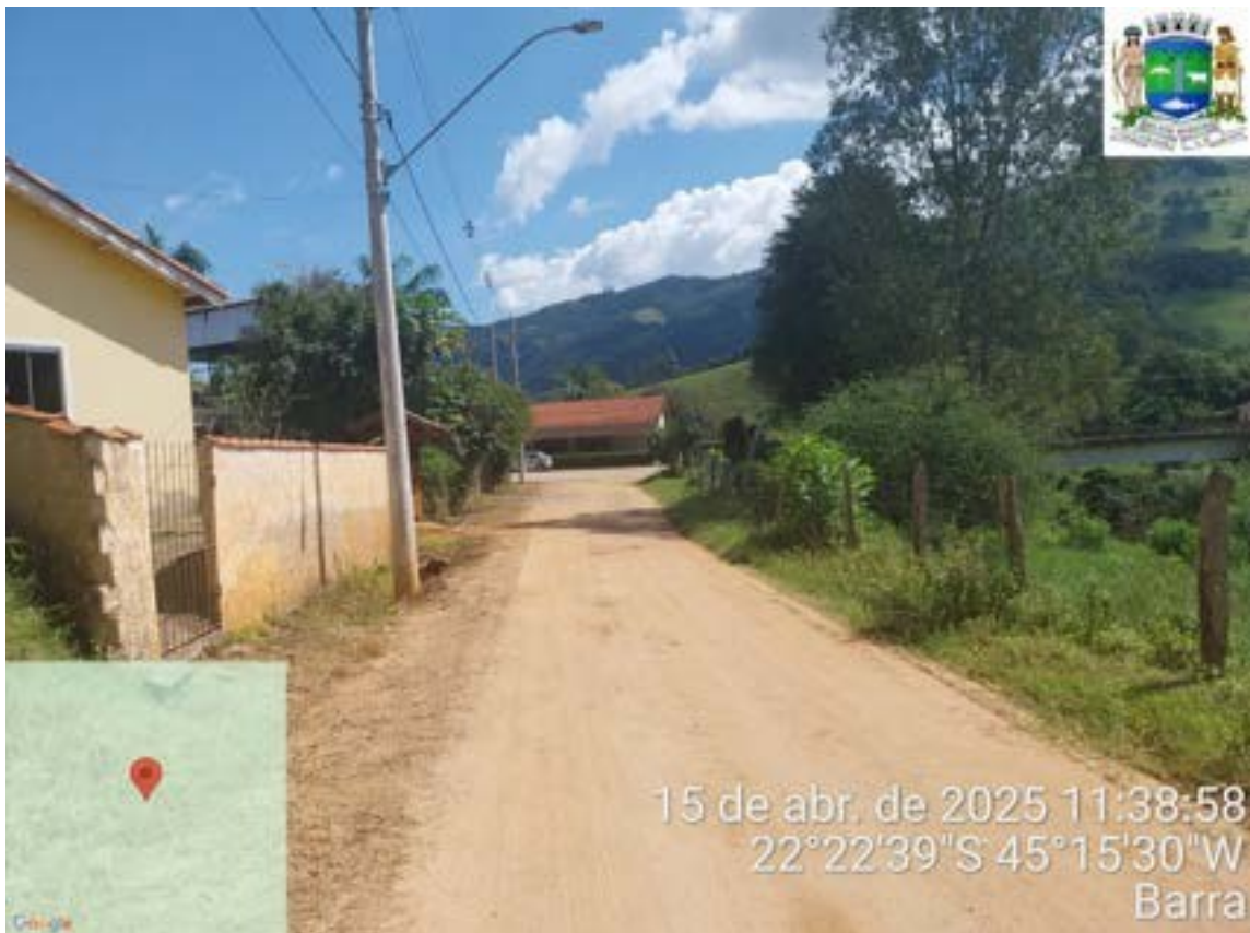
Barra – Trecho 1- Estaca 3 até Estaca 4
