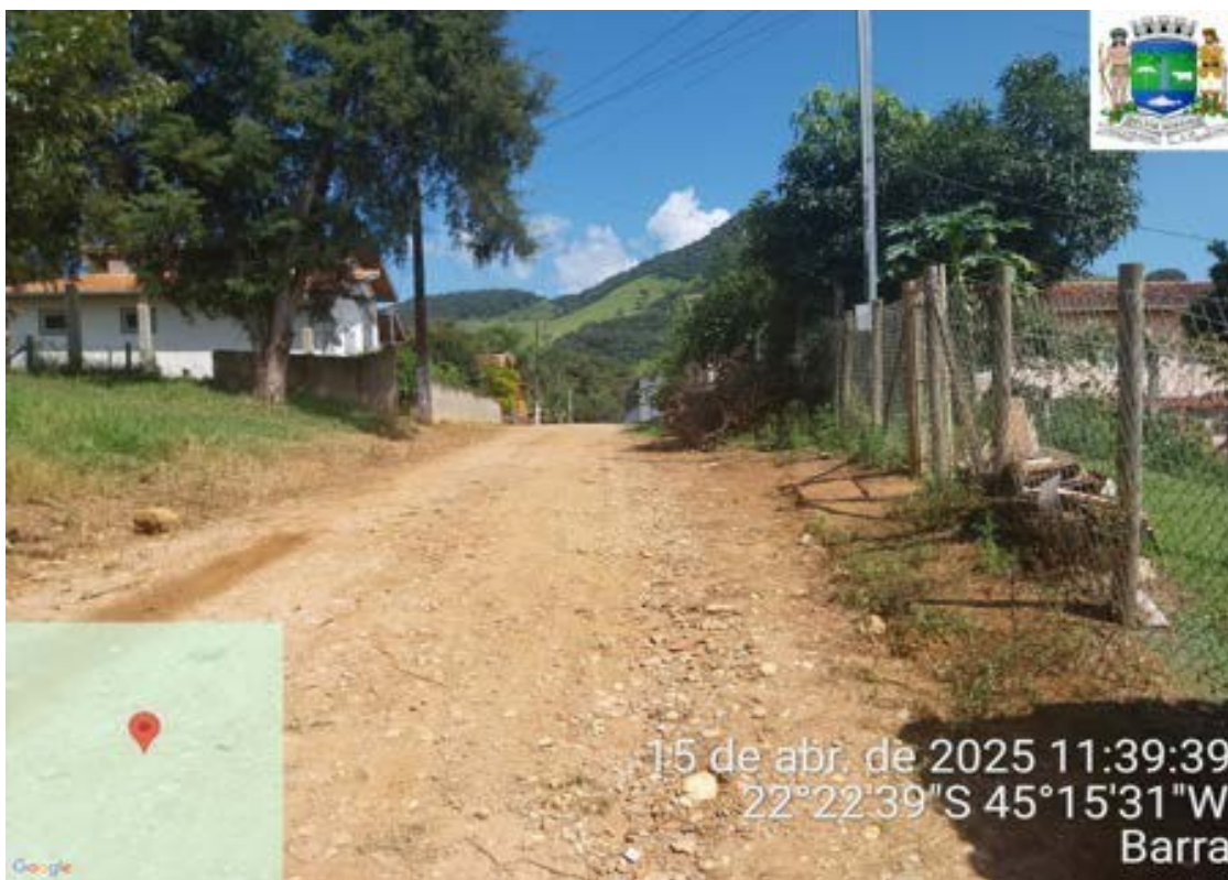
Barra – Trecho 2- Estaca 2 até Estaca 3
