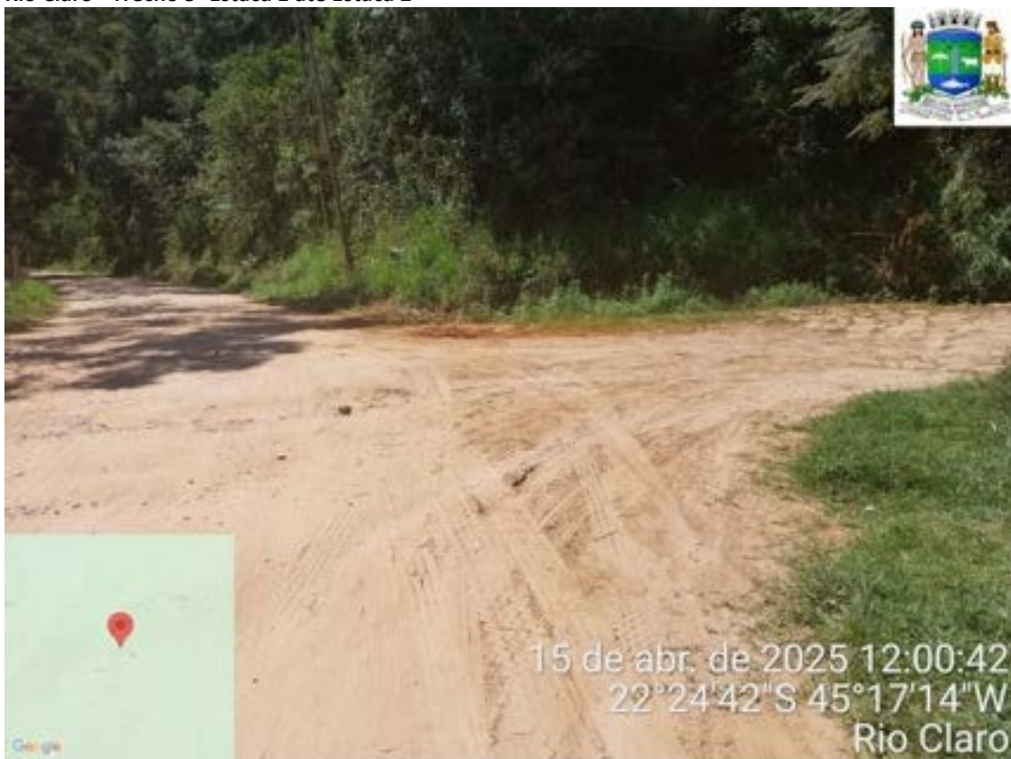
Rio Claro- Trecho 5- Entre estacas 1 e 2
