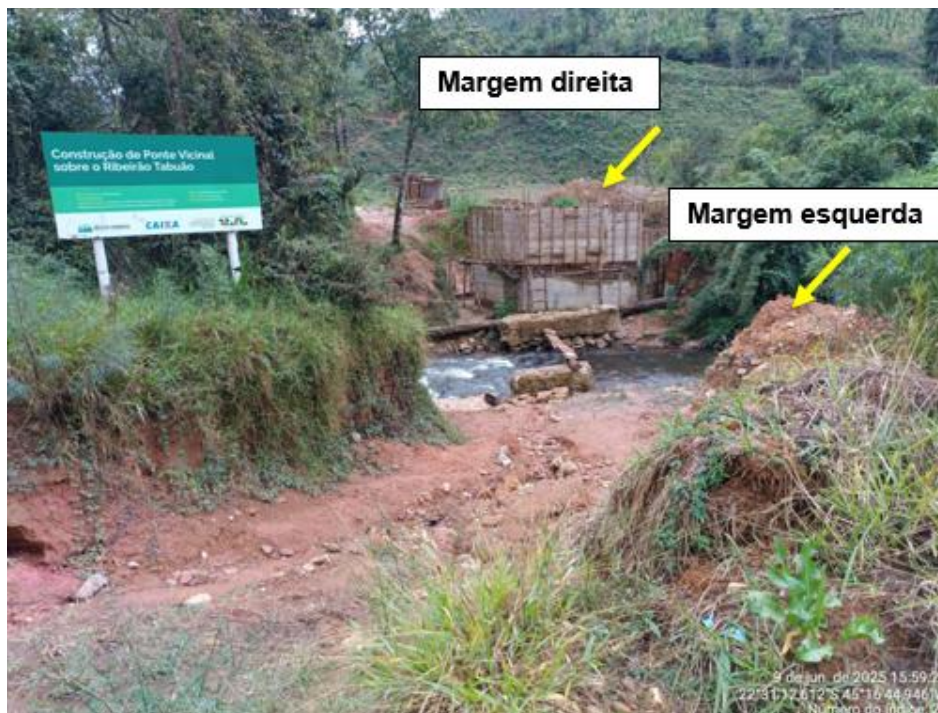
Imagem 3 – Identificação das margens da ponte inacabada Fonte: Acervo pessoal da Projeta Engenharia
