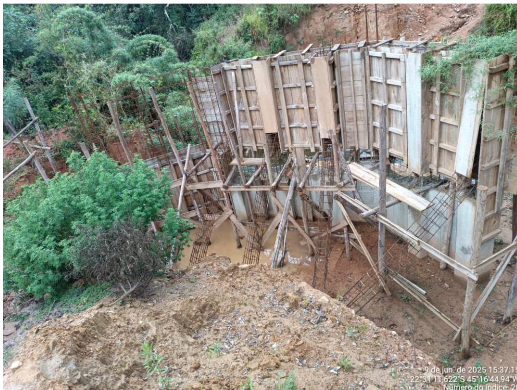
Imagem 5 – Vista dos fundos da estrutura inacabada Fonte: Acervo pessoal da Projeta Engenharia
