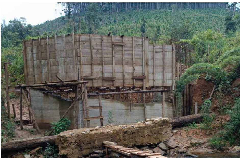
Imagem 4 – Vista frontal da estrutura inacabada Fonte: Acervo pessoal da Projeta Engenharia
