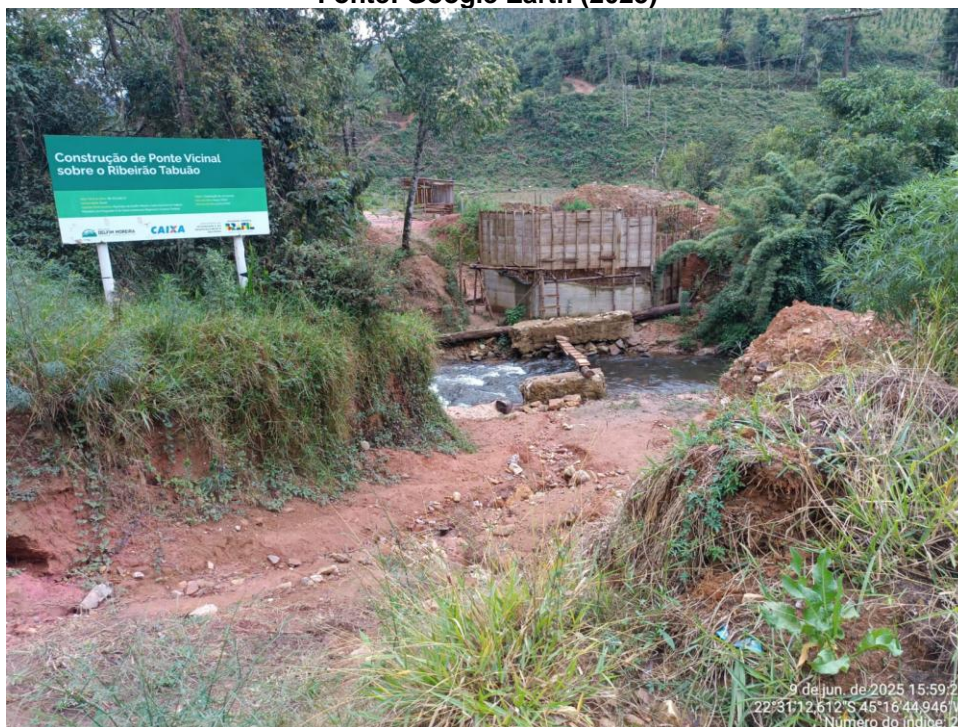
Imagem 2: Vista frontal da ponte inacabada Fonte: Acervo pessoal da Projeta Engenharia
