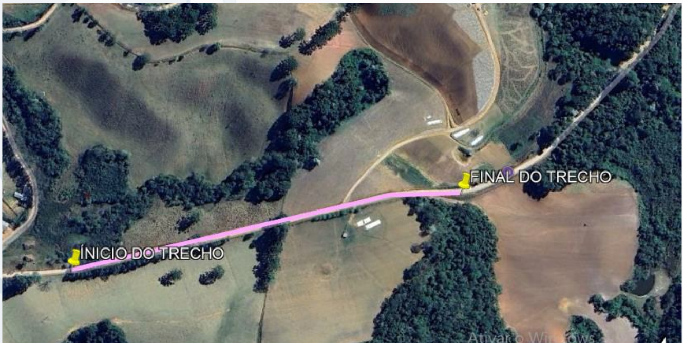
Foto 1: Foto Aérea do Trecho.
