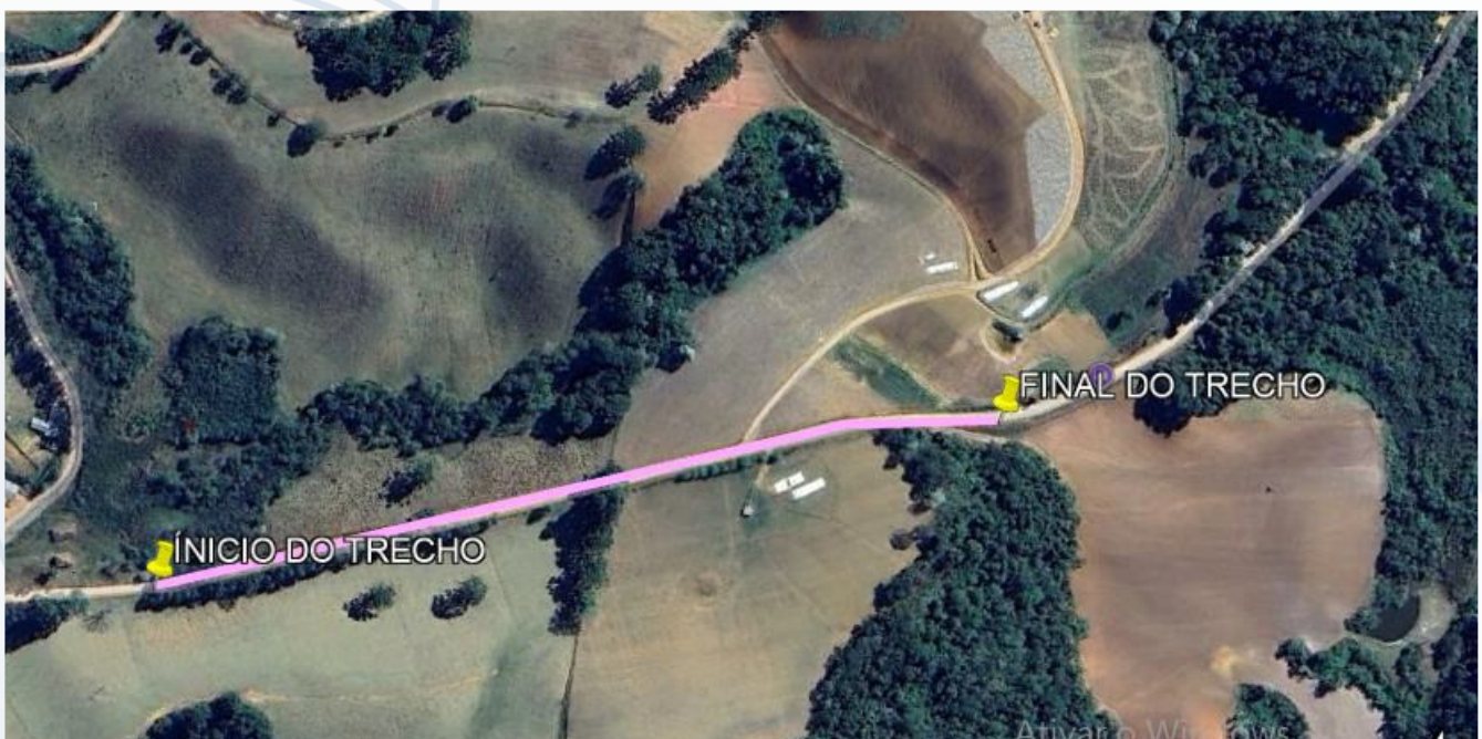
Foto 01 – Localização do Calçamento
