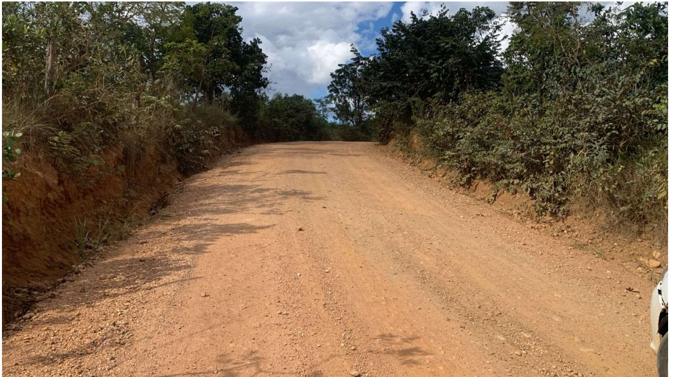
Foto 12: Morro da Cuia, localizado na Estrada Vicinal que interliga os Distritos de Vila Amanda e Vargem Grande à Comunidade da Cuia no Município de Baldim-MG. Fonte: Próprio Autor, 2026.
