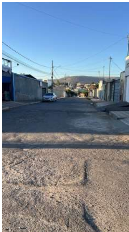
Foto 2 – Antes das obras – 27/06/2025
