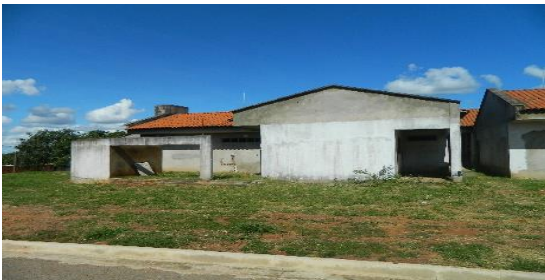
Figura 2 - Vista do terreno lateral do bloco de serviços. Fonte: OBRAS 2.0 – Histórico SIMEC
