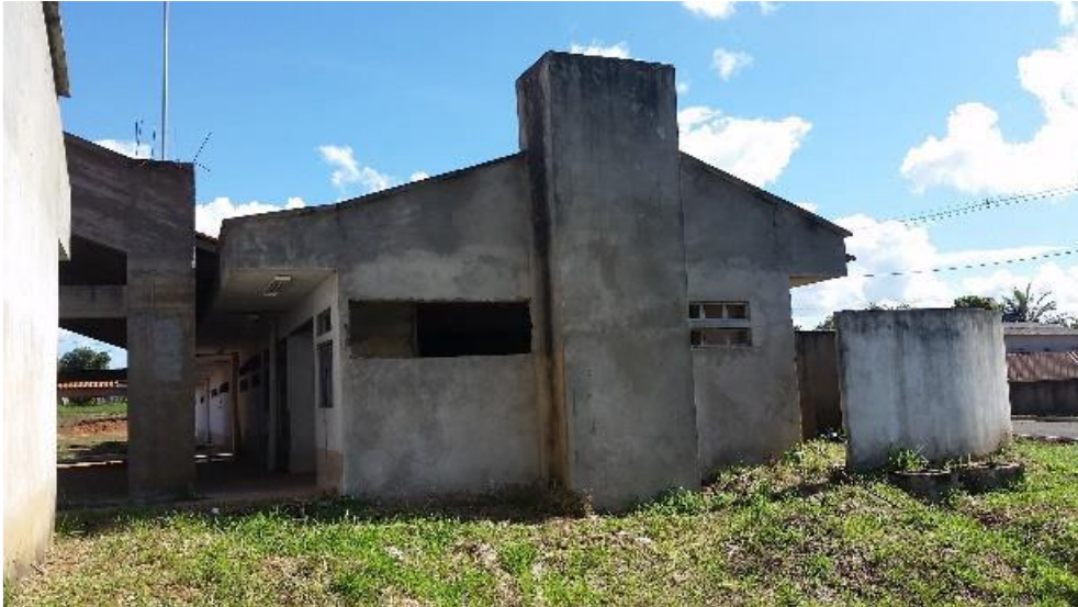
Figura 3 - Vista frontal do terreno do bloco serviços. Fonte: OBRAS 2.0 – Histórico SIMEC
