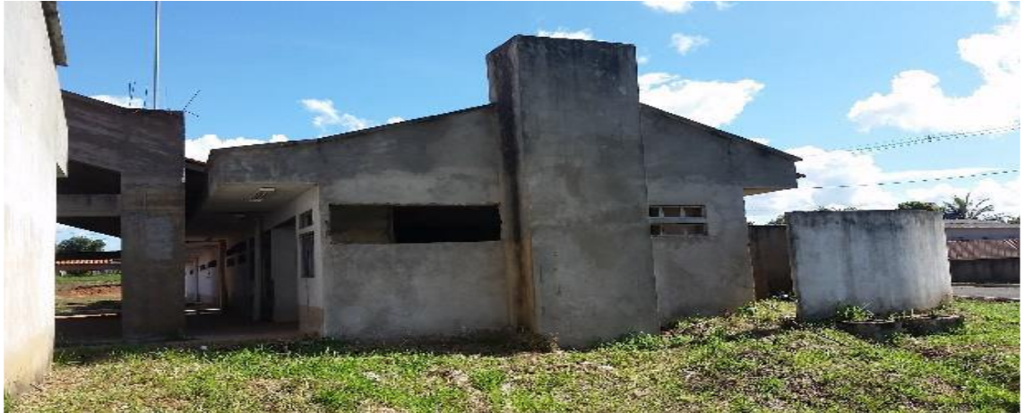
Figura 17 – Vista frontal bloco de serviço. Fonte: OBRAS 2.0 – Histórico SIMEC
