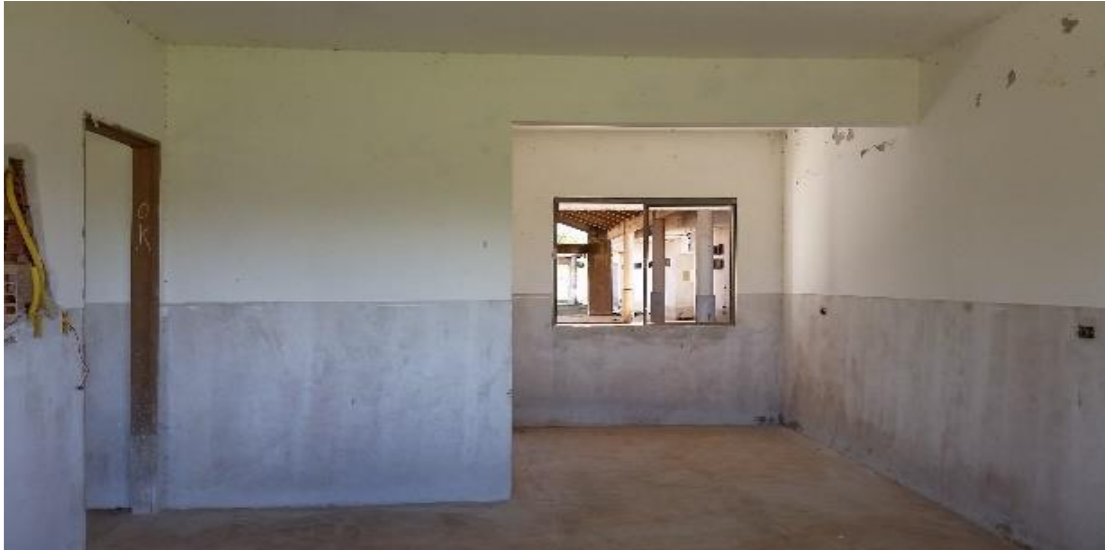
Figura 6 – Bloco administrativo com alvenaria, piso, divisórias, chapisco, embosso e reboco executados.
