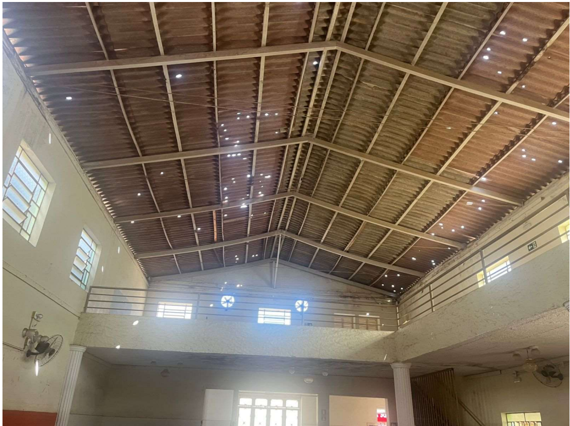
FOTO 02: COBERTURA DO CLUBE RODANES
