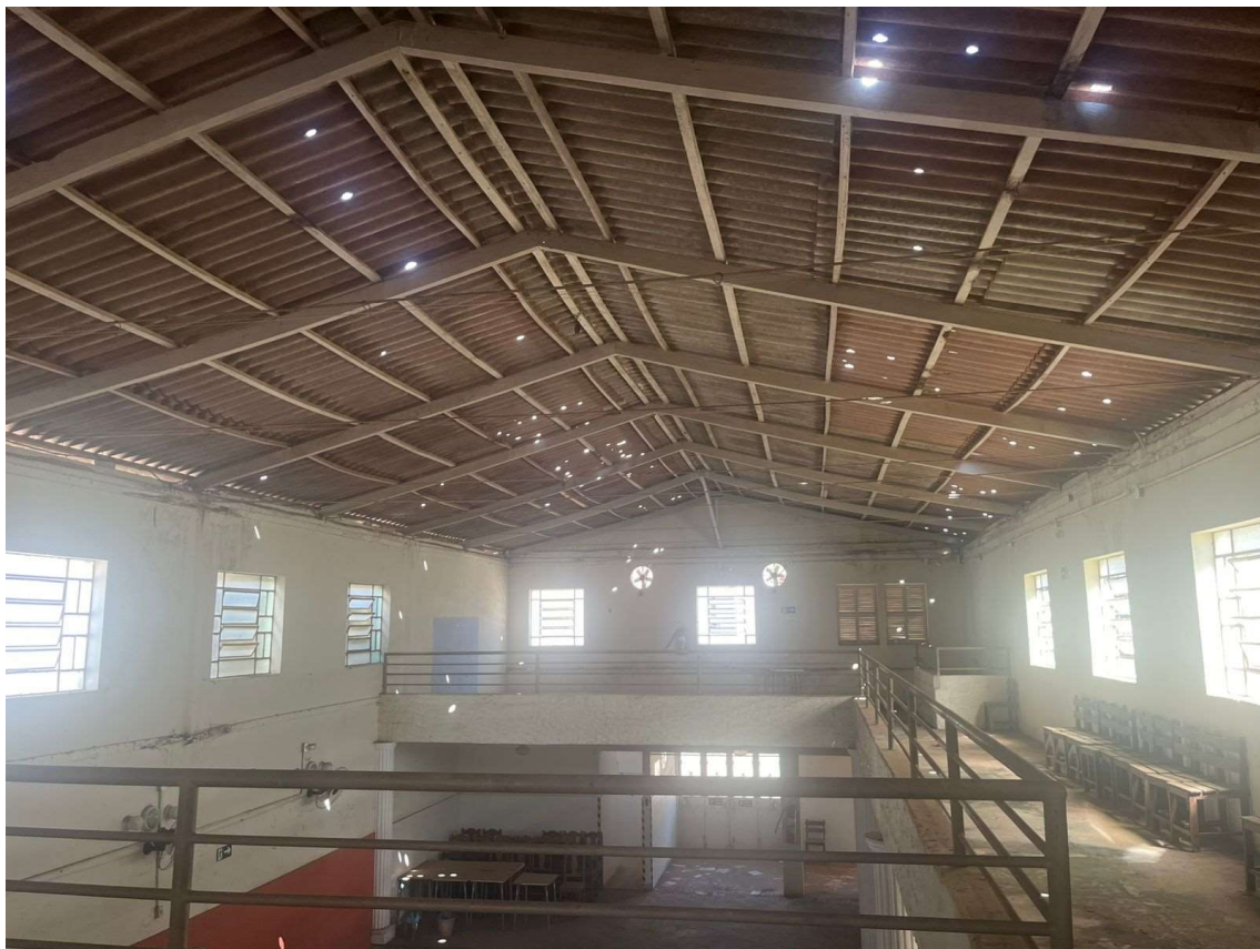
FOTO 01: COBERTURA DO CLUBE RODANES
