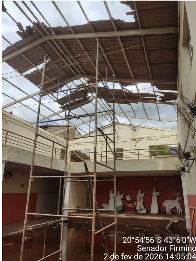
FOTO 04: COBERTURA DO CLUBE RODANES
