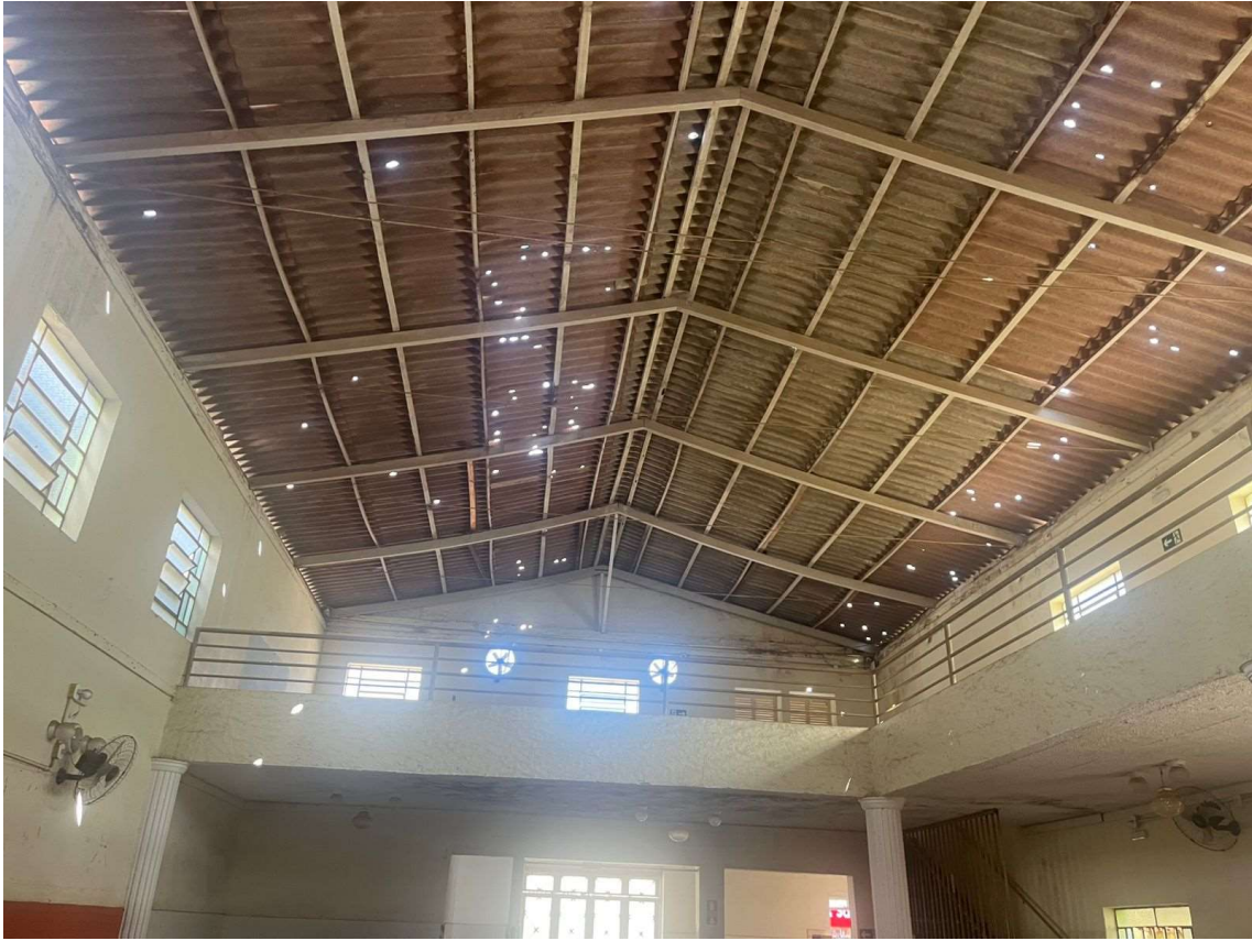
FOTO 02: COBERTURA DO CLUBE RODANES
