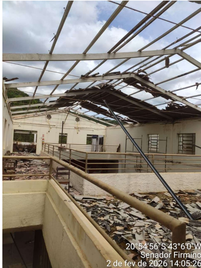
FOTO 03: COBERTURA DO CLUBE RODANES
