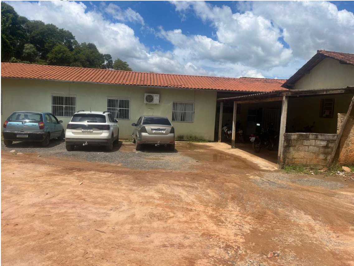
FOTO 02: Local que será calçado
