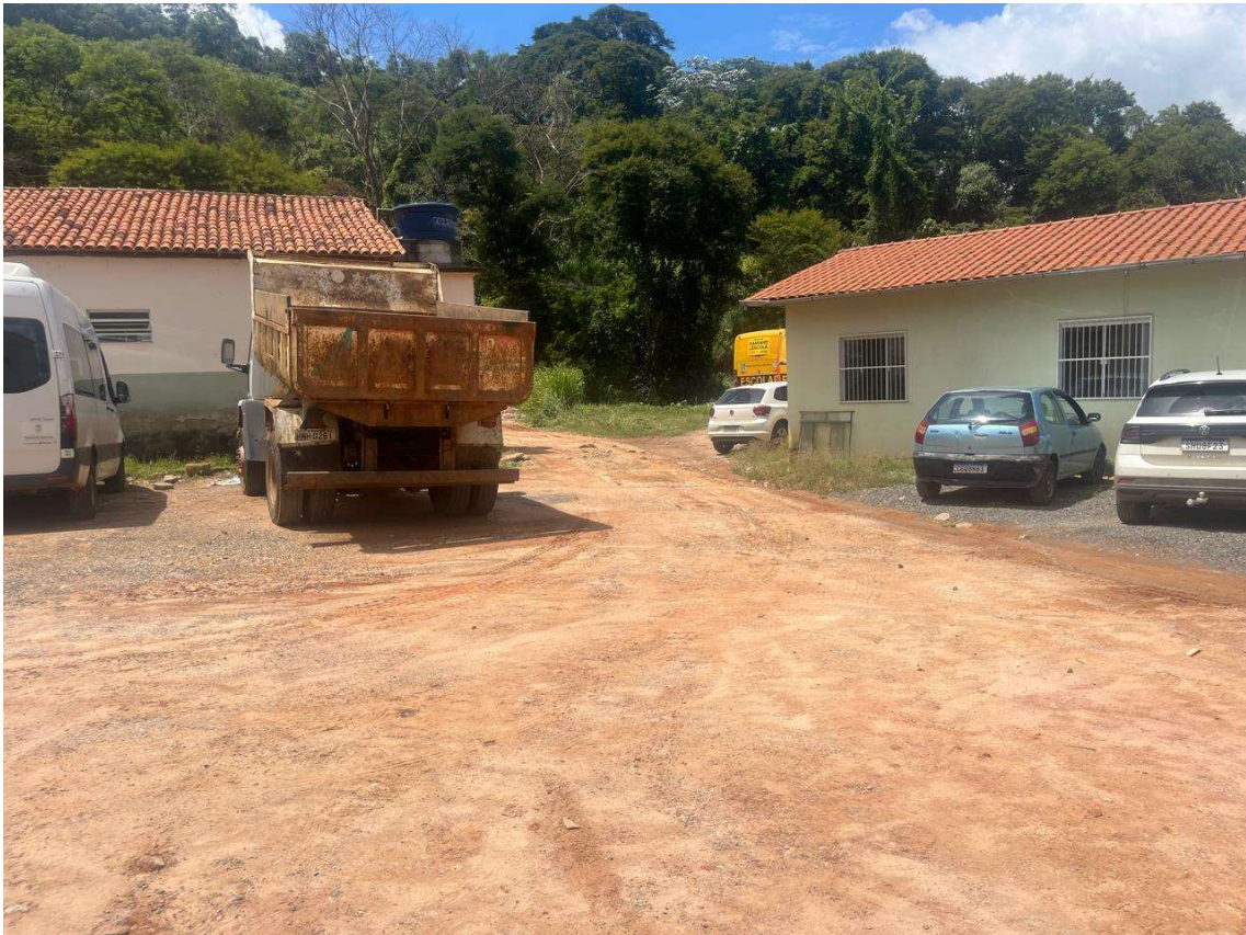
FOTO 01: Local que será calçado
