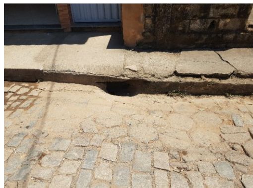
Boca de lobo existente -20.987778, -43.015
