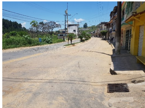
1 - Início do trecho (detalhe bueiro existente) -20.987778, -43.015
