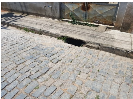
Boca de lobo existente -20.987778, -43.015
