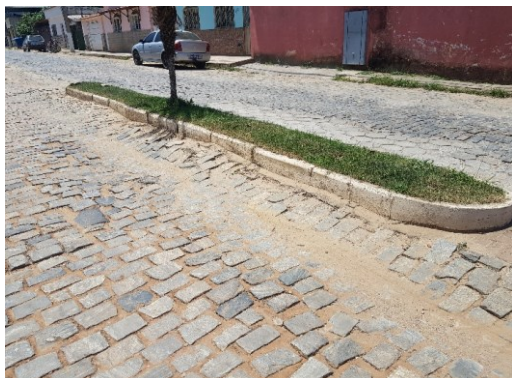
Detalhe do calçamento -20.988611, -43.013889
