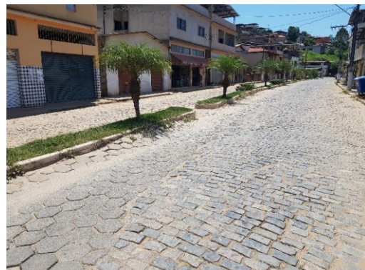
Detalhe do calçamento -20.988333, -43.014167
