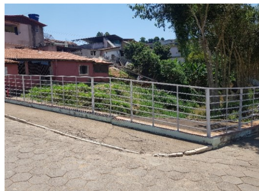
Local de deságue da rede de drenagem -20.987778, -43.015
