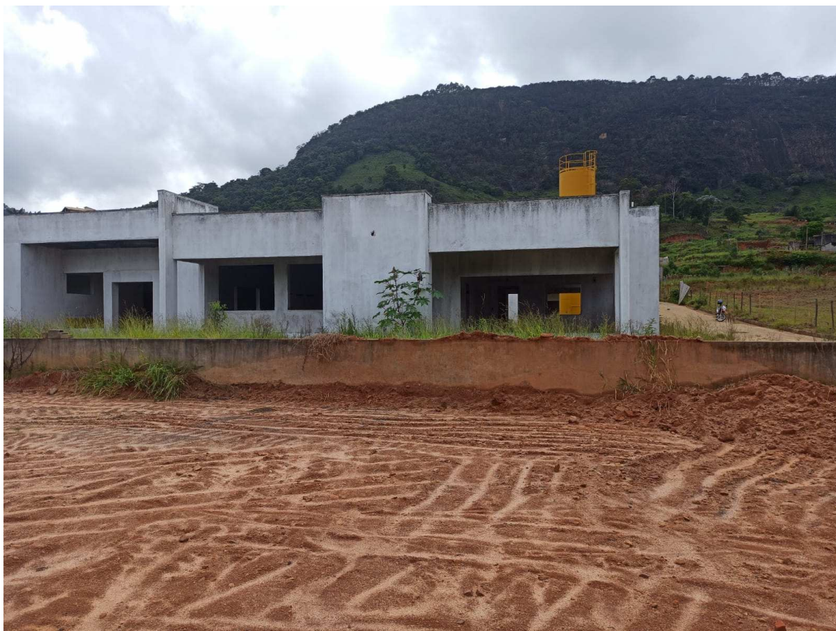
Figura 3 – Vista frontal da creche. Fonte: elaboração própria
