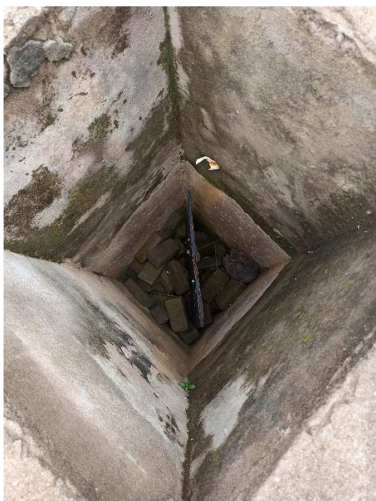
Figuras 36,37 e 38 respectivamente, caixas de passagem e tubulação de água pluvial obstruídas por vegetação e entulhos. Fonte: elaboração própria
