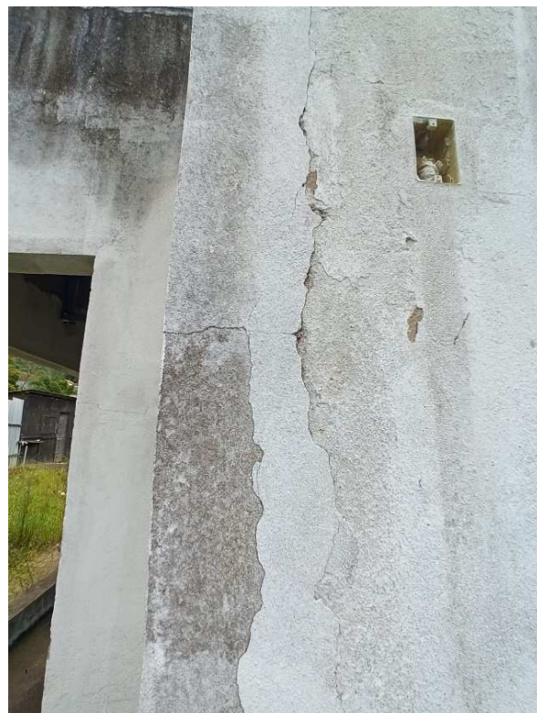
Figura 34 e 35- Trincas verticais na estrutura. Trincas nas junções dos acréscimos das alvenarias de embutimentos das prumadas com a alvenaria existente da edificação, sem execução do correto travamento com telas e amarração das alvenarias. Fonte: elaboração própria.
