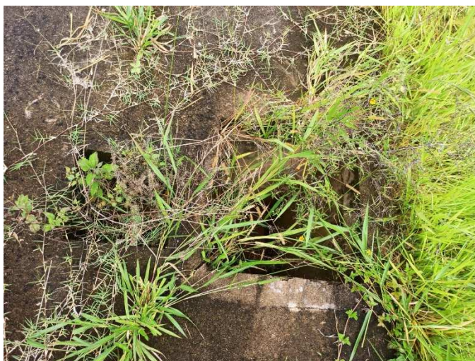
Figuras 36,37 e 38 respectivamente, caixas de passagem e tubulação de água pluvial obstruídas por vegetação e entulhos. Fonte: elaboração própria
