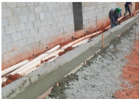
FIGURA: Exemplo de execução de sarjeta moldada in-loco
