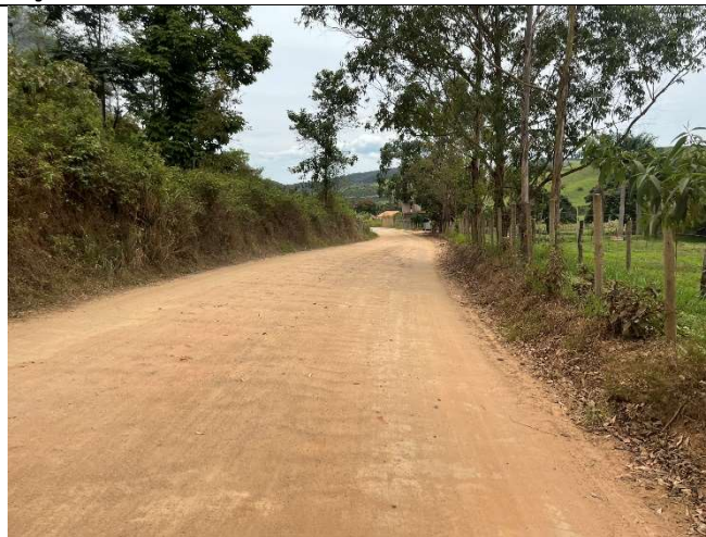
Observações: Trecho Final da Intervenção
