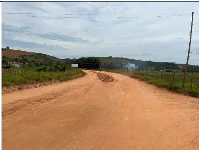
Observações: Trecho intermediário
