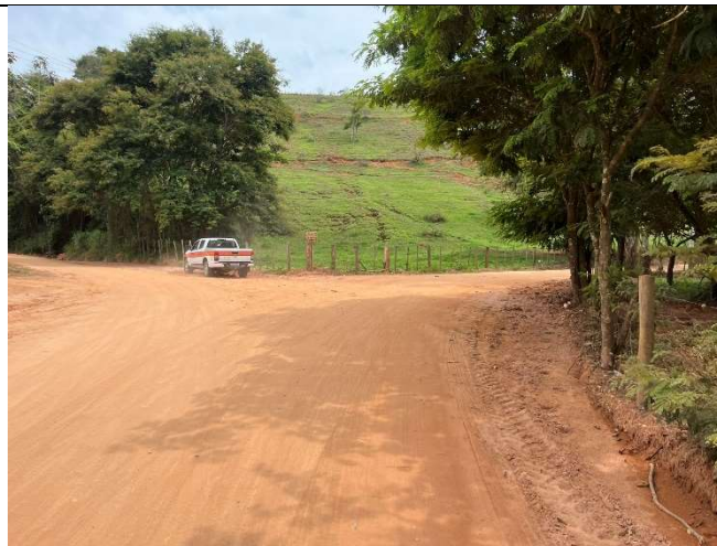
Observações: Trecho intermediário - entroncamento
