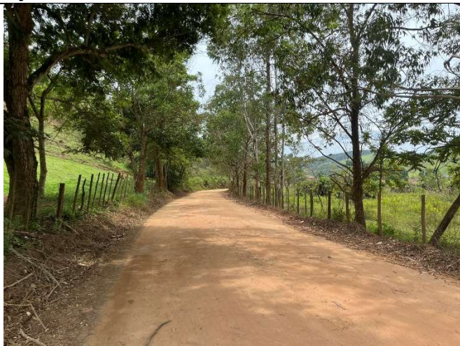
Observações: Trecho intermediário
