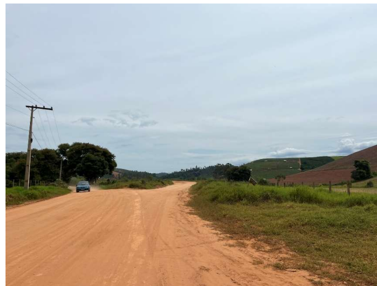
Observações: Trecho de entroncamento
