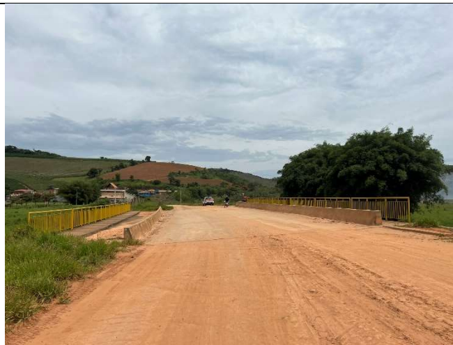
Observações: Ponte Existente no Trecho
