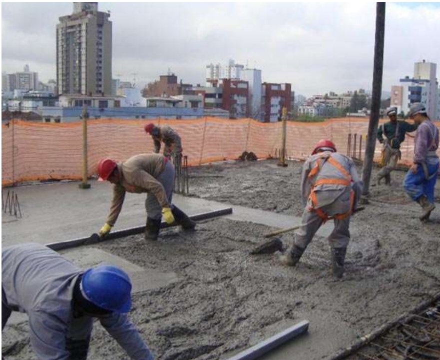
Sarrafeamento durante concretagem
