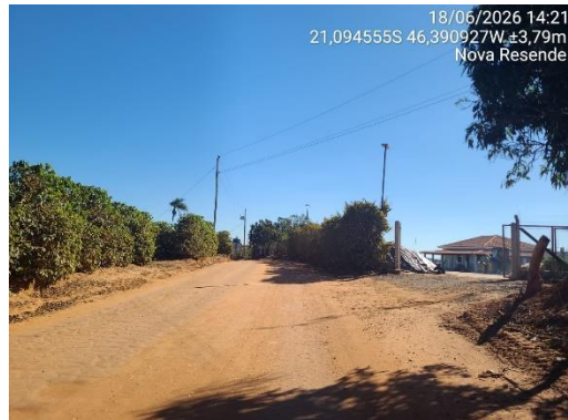
FOTO 06 - Estrada vicinal de Nova Resende ao Bairro Serra II – Trecho 01.
