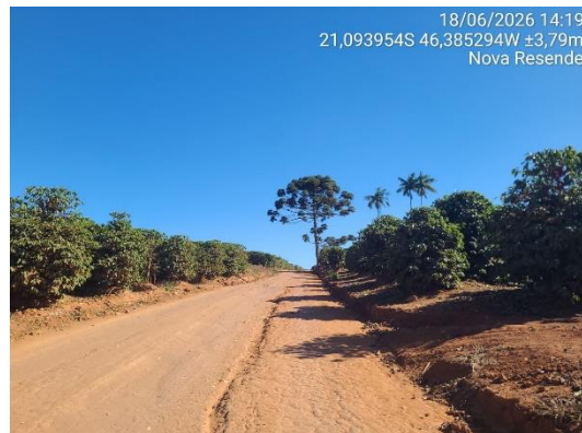
FOTO 12 - Estrada vicinal de Nova Resende ao Bairro Serra II – Trecho 01.
