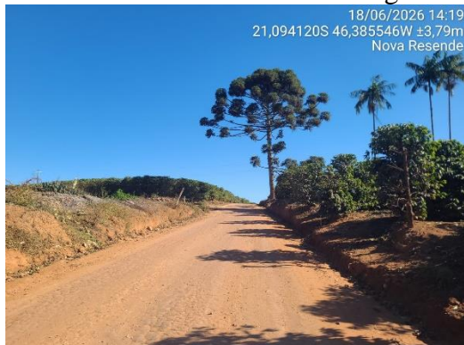
FOTO 01 - Estrada vicinal de Nova Resende ao Bairro Serra II – Trecho 01.
