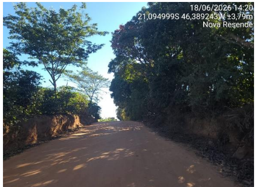
FOTO 05 - Estrada vicinal de Nova Resende ao Bairro Serra II – Trecho 01.
