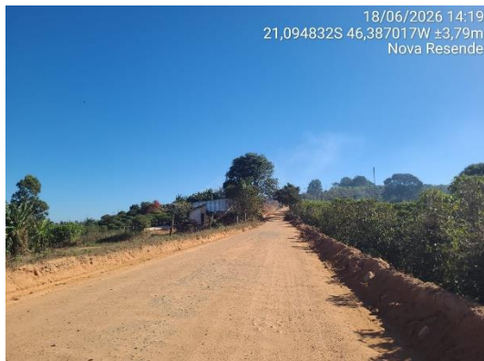
FOTO 11 - Estrada vicinal de Nova Resende ao Bairro Serra II – Trecho 01.
