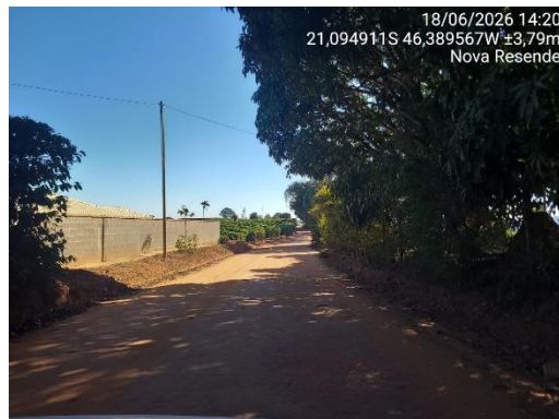
FOTO 04 - Estrada vicinal de Nova Resende ao Bairro Serra II – Trecho 01.
