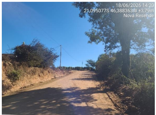
FOTO 03 - Estrada vicinal de Nova Resende ao Bairro Serra II – Trecho 01.
