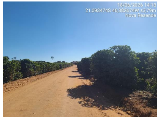
FOTO 10 - Estrada vicinal de Nova Resende ao Bairro Serra II – Trecho 01.
