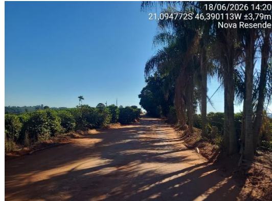
FOTO 08 - Estrada vicinal de Nova Resende ao Bairro Serra II – Trecho 01.
