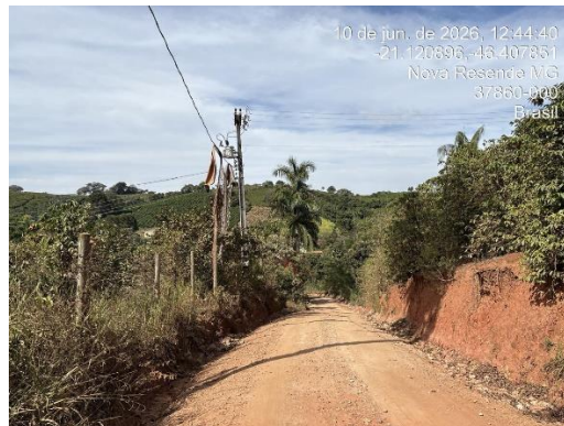
FOTO 02 - Estrada vicinal de Nova Resende ao Bairro Mundo Novo.
