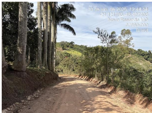
FOTO 13 - Estrada vicinal de Nova Resende ao Bairro Mundo Novo.
