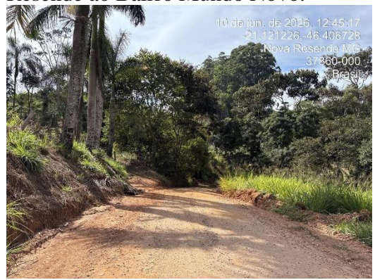
FOTO 10 - Estrada vicinal de Nova Resende ao Bairro Mundo Novo.
