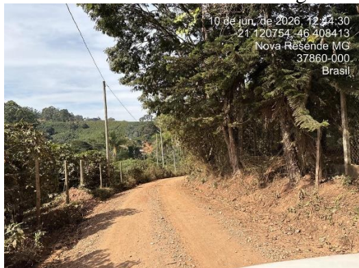
FOTO 01 - Estrada vicinal de Nova Resende ao Bairro Mundo Novo.
