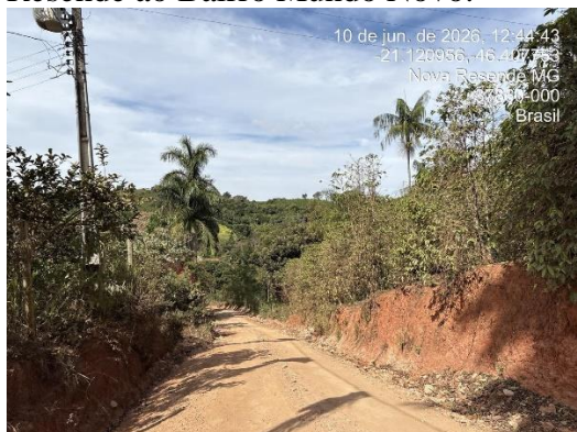
FOTO 03 - Estrada vicinal de Nova Resende ao Bairro Mundo Novo.
