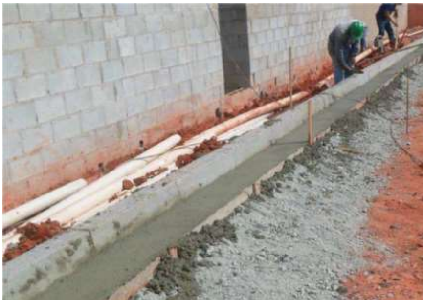
Figura 1 - Exemplo de execução de sarjeta moldada in loco após execução do meio-fio pré-moldado
