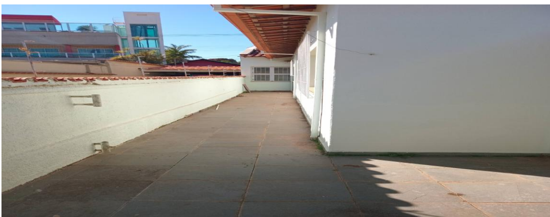
Foto 21 Corredor externo Lateral à área lavanderia
