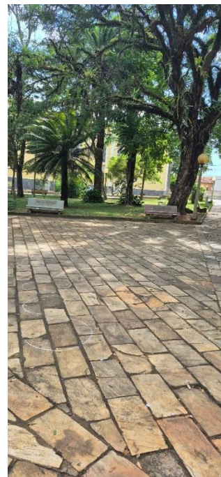
Praça Coronel Neves: piso com sujidades
