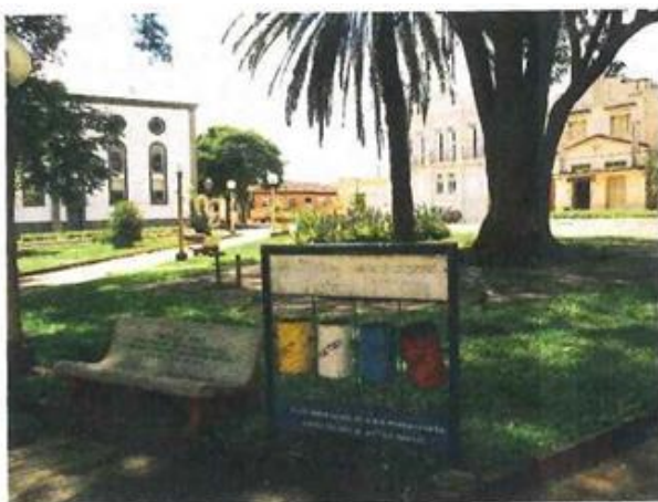
Foto 002 – Vista geral da Praça com visada para osobrado Município de Boa Esperança Data: 24/03/2008
