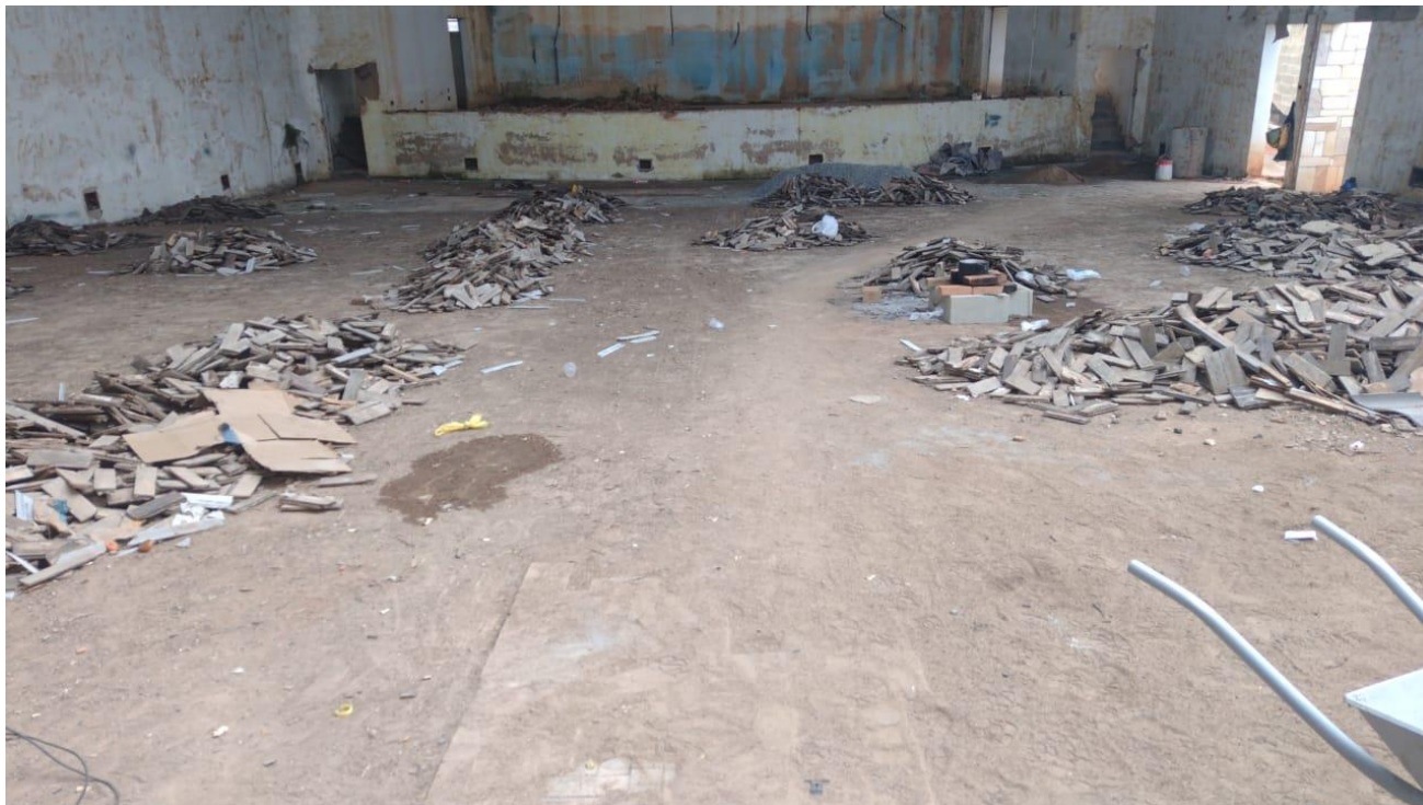
Figura 01: Piso antigo removido.
