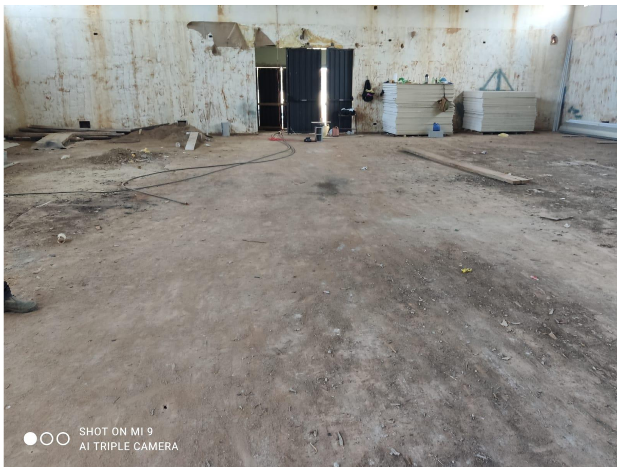
Figura 02: Área em que o novo piso será colocado.
