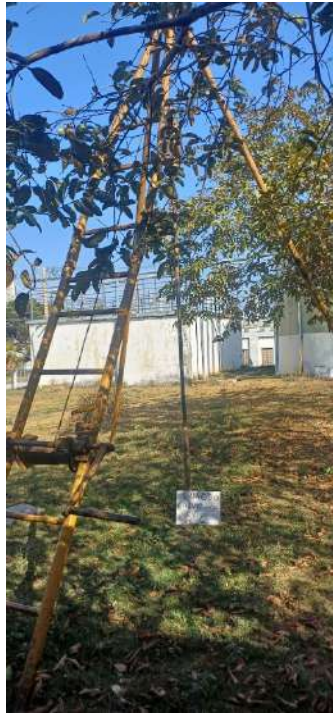
EXECUÇÃO DA SONDAGEM
