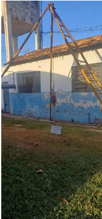
EXECUÇÃO DA SONDAGEM
