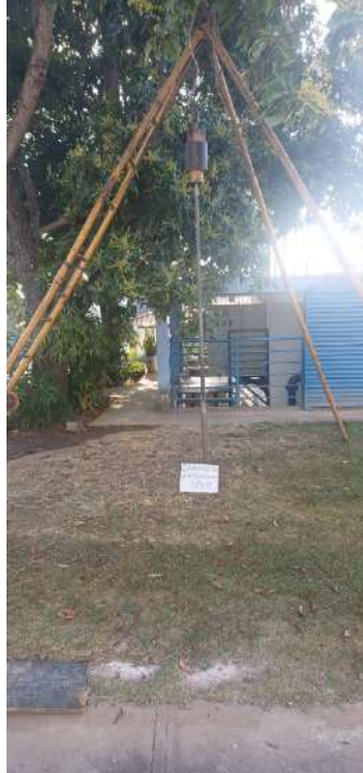
EXECUÇÃO DA SONDAGEM
