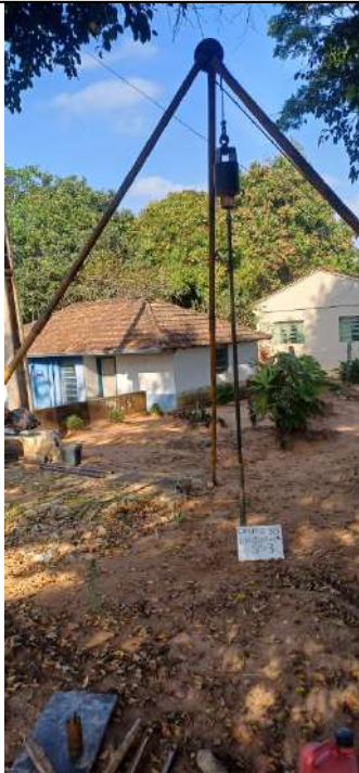
EXECUÇÃO DA SONDAGEM
