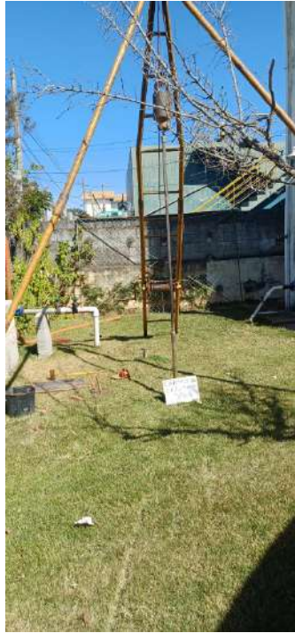
EXECUÇÃO DA SONDAGEM
