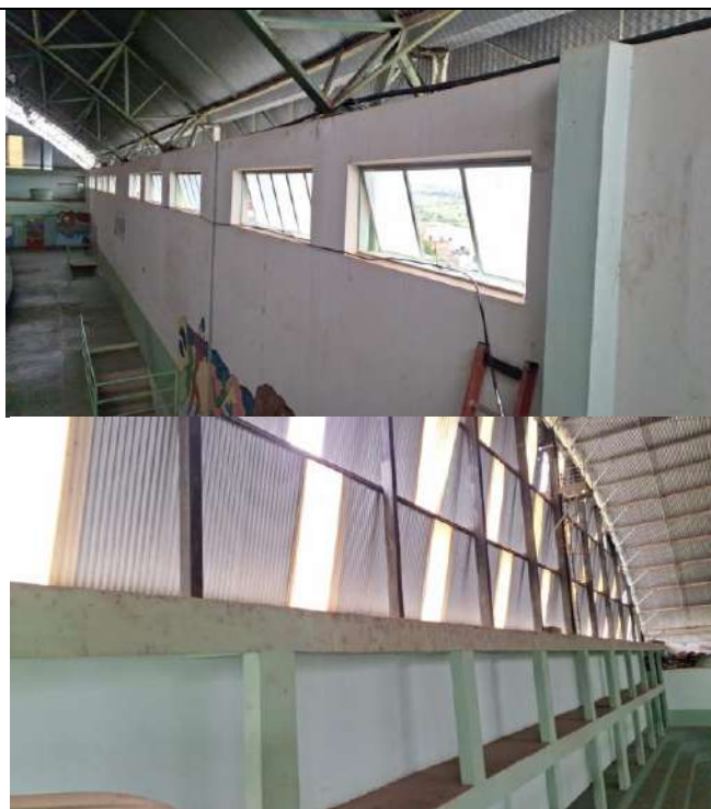
6 – Passagem de cabos
