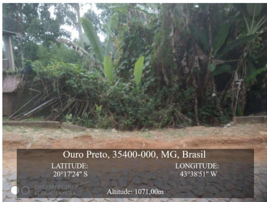
Imagem 02: Vista frontal do calçamento e meio-fio.
